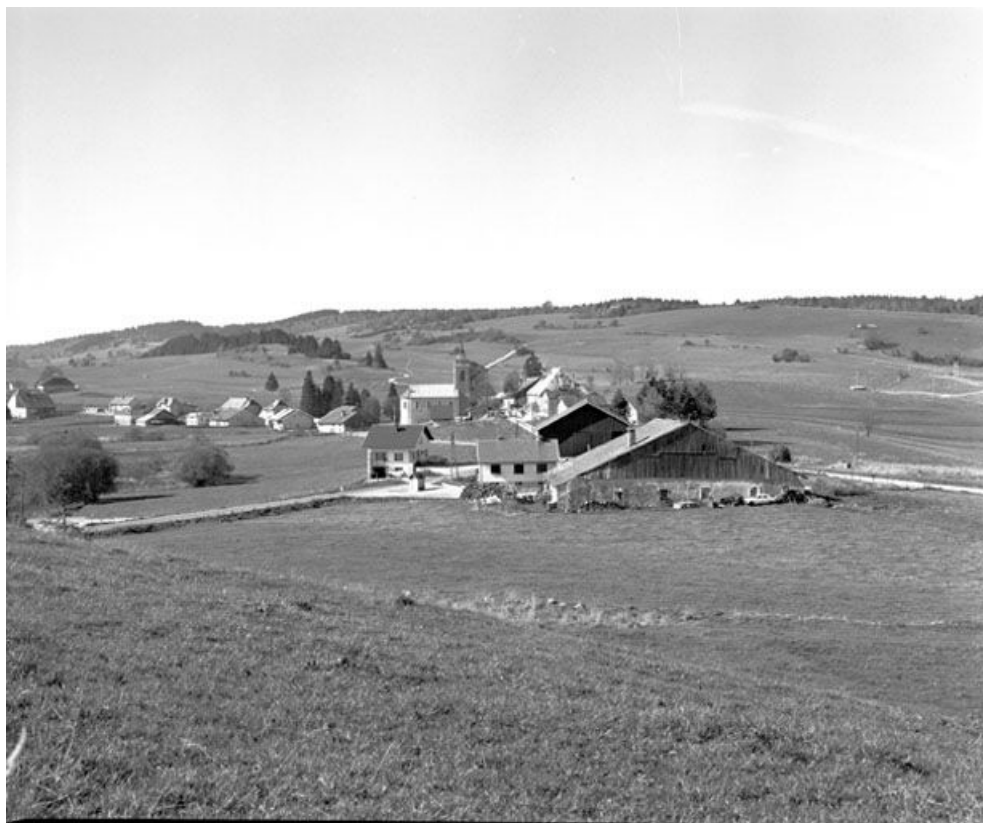
Vue d'ensemble du village, depuis le nord-est. 25, Gellin
