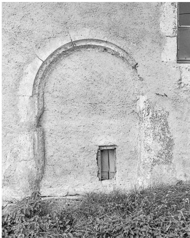
Détail de la façade sur rue : porte murée.
