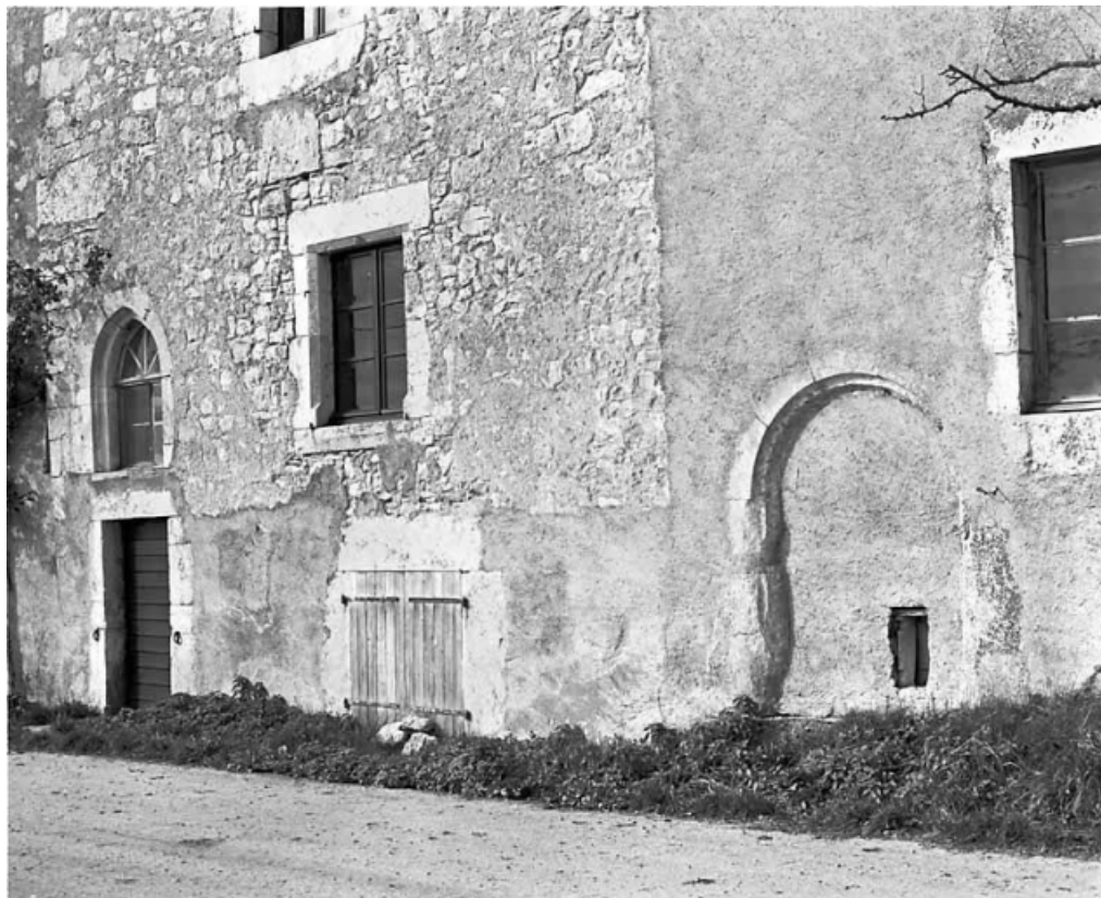
Façade sur rue, partie centrale.
