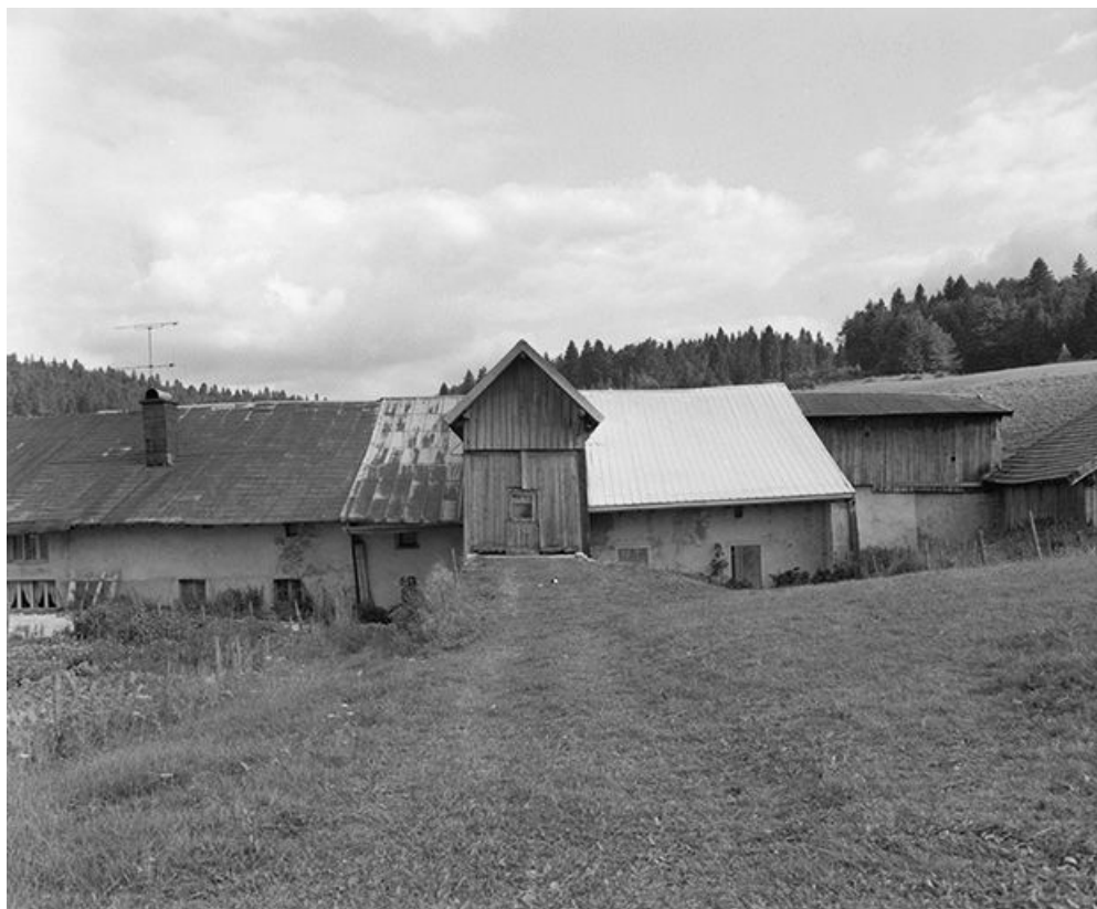
Façade postérieure avec pont de grange.
