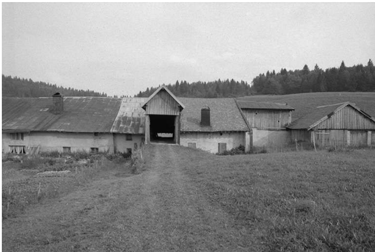
Façade postérieure avec pont de grange.
