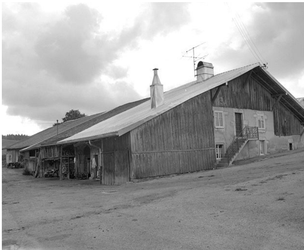
Façades antérieure et latérale gauche. 25, Le Crouzet rue Sainte-Anne
