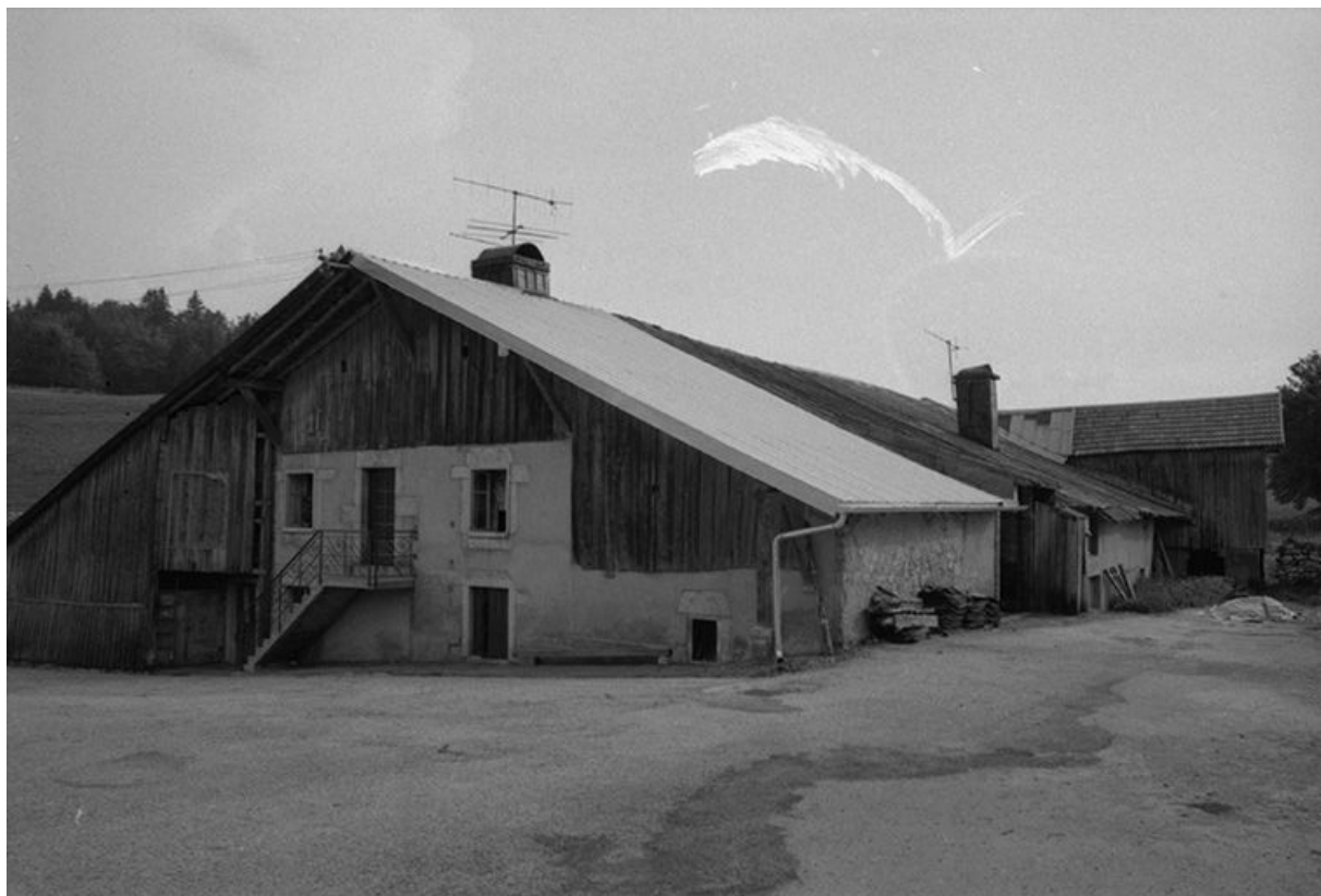
Façades antérieure et latérale droite. 25, Le Crouzet rue Sainte-Anne
