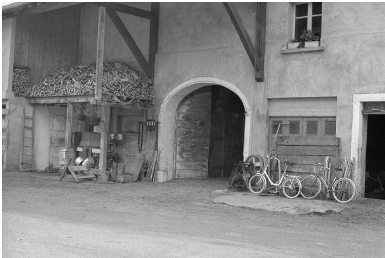
Ferme datée de 1730, située Grande Rue : façade antérieure. 25, Le Crozet
