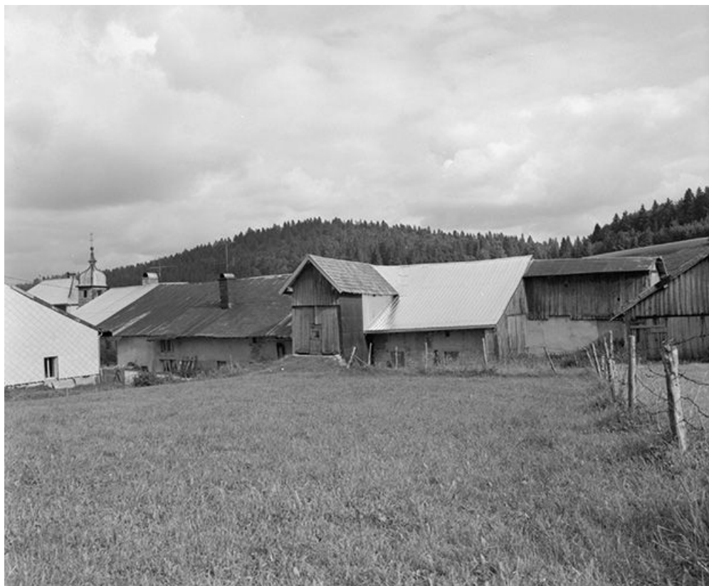
Ferme situées rue de la Fontaine : façades postérieures.
