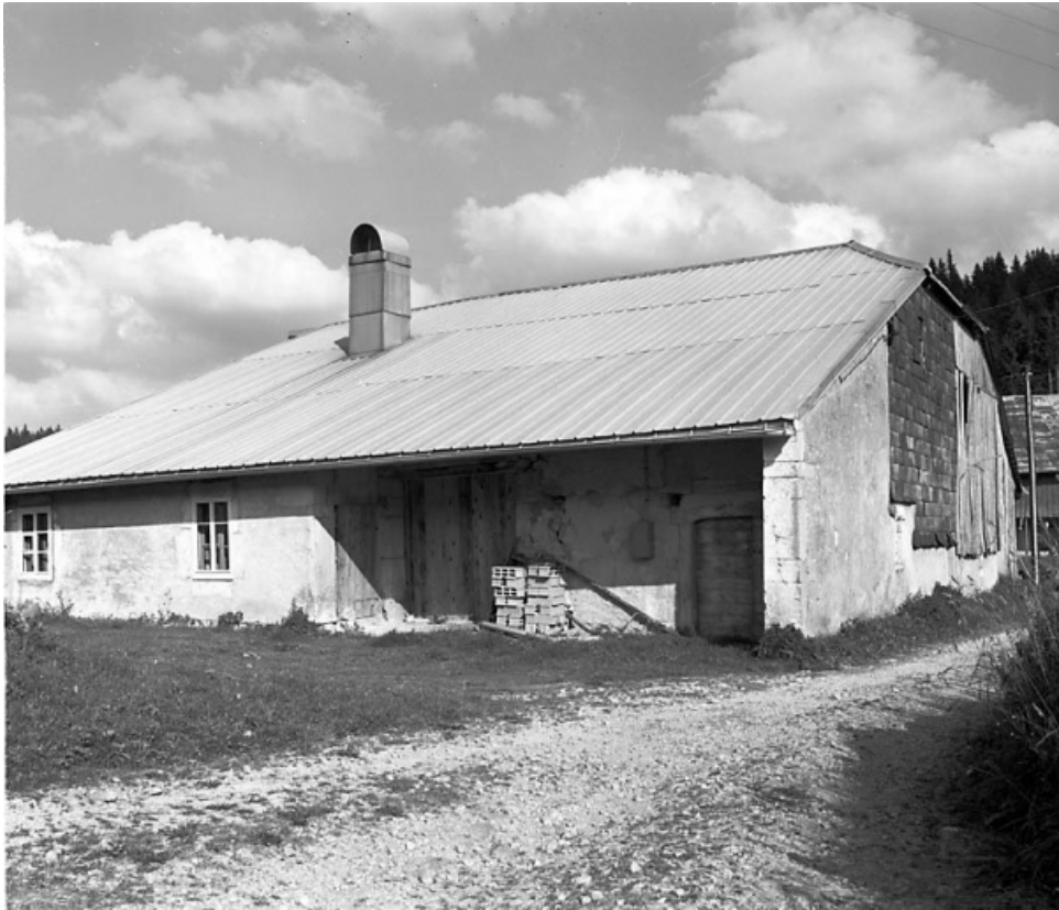
Façades postérieure et latérale gauche.
