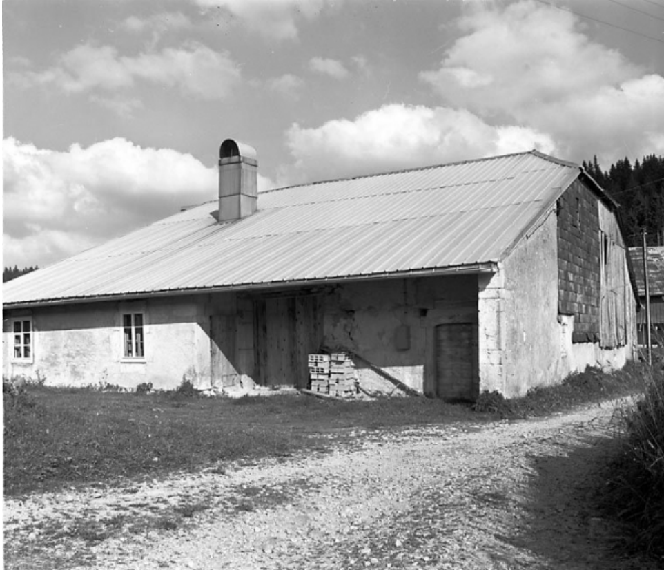
Façades postérieure et latérale gauche.
