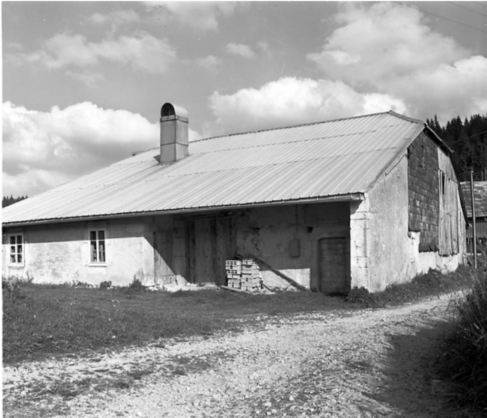
Façades postérieure et latérale gauche.
