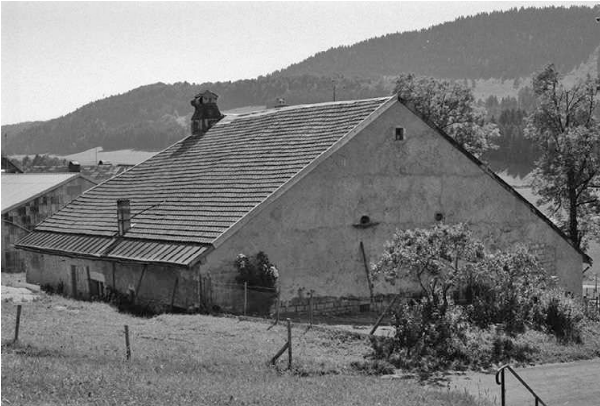
Façades postérieure et latérale gauche. 25, Chaux-Neuve rue de l' Eglise
