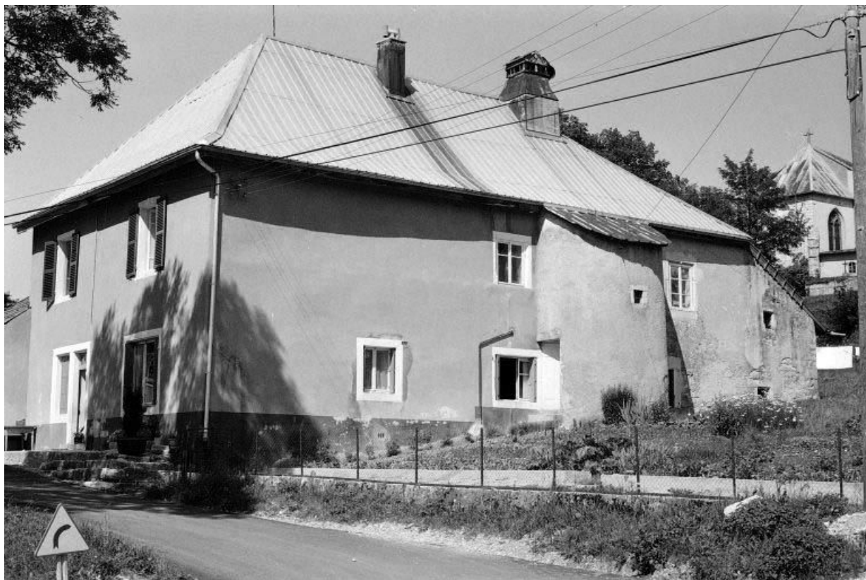
Façades antérieure et latérale droite. 25, Chaux-Neuve rue de l' Eglise
