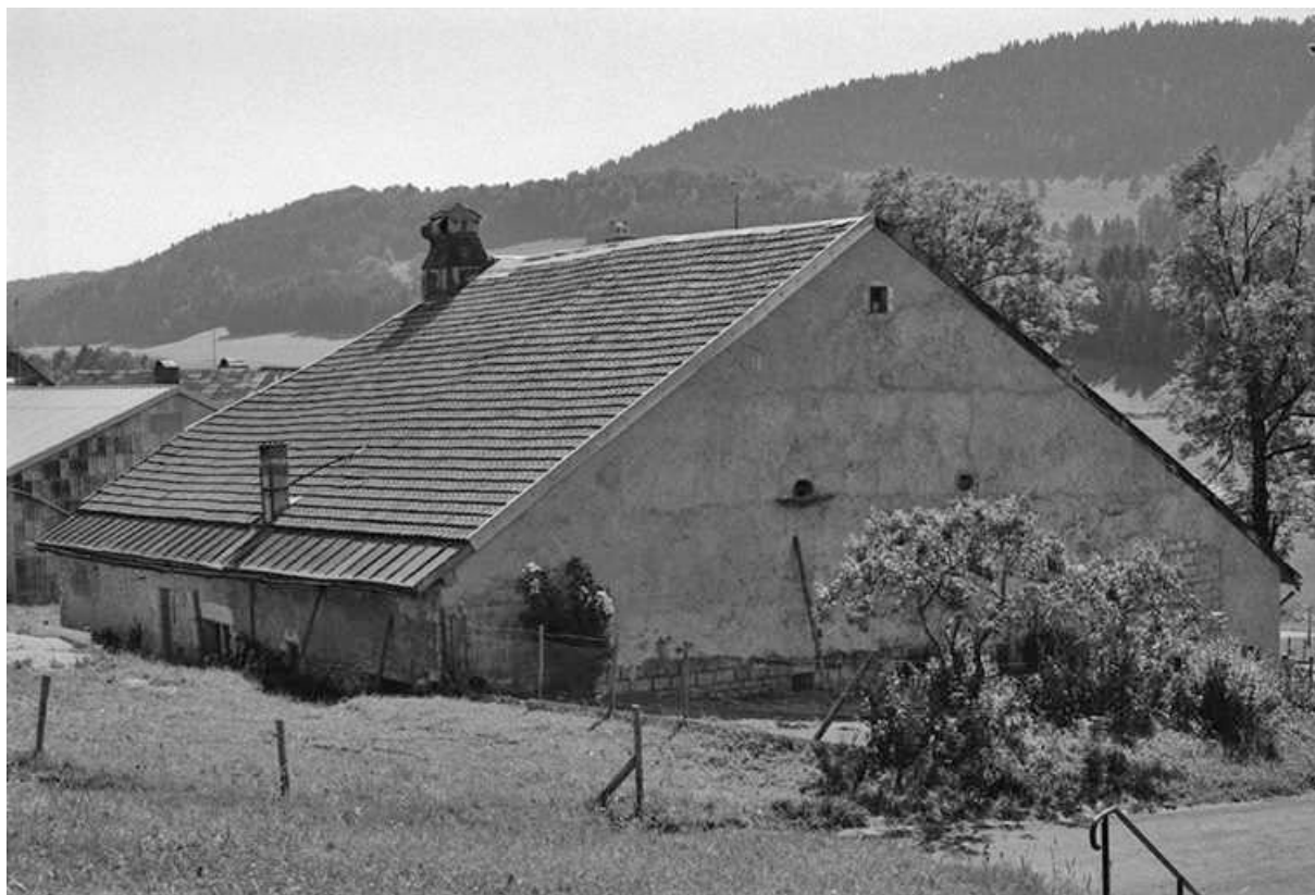
Façades postérieure et latérale gauche.
