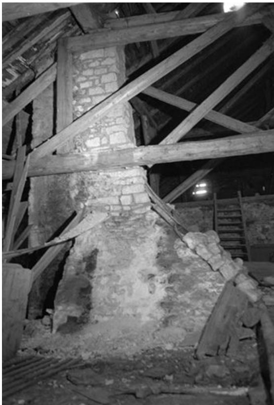
Intérieur : charpente et cheminée.
