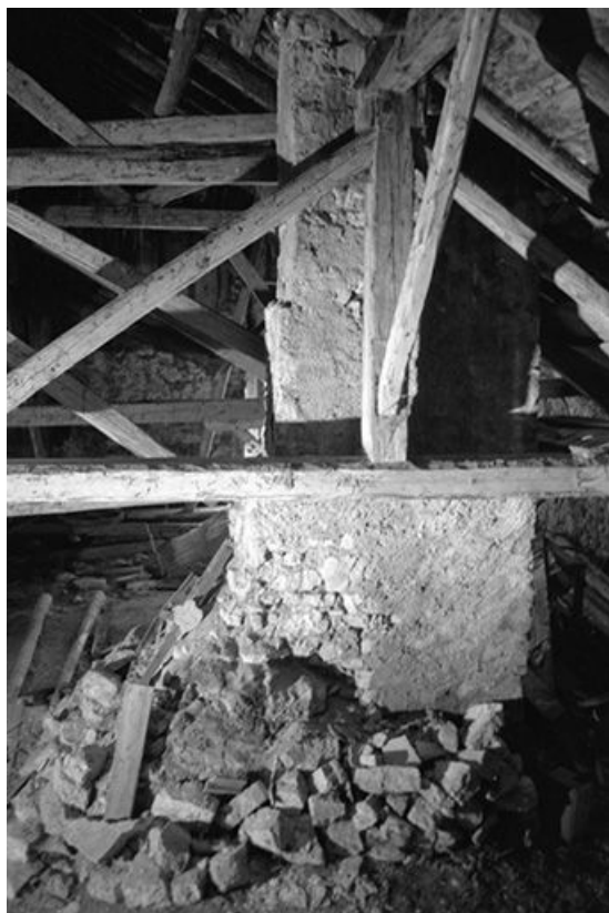
Intérieur : charpente et cheminée.
