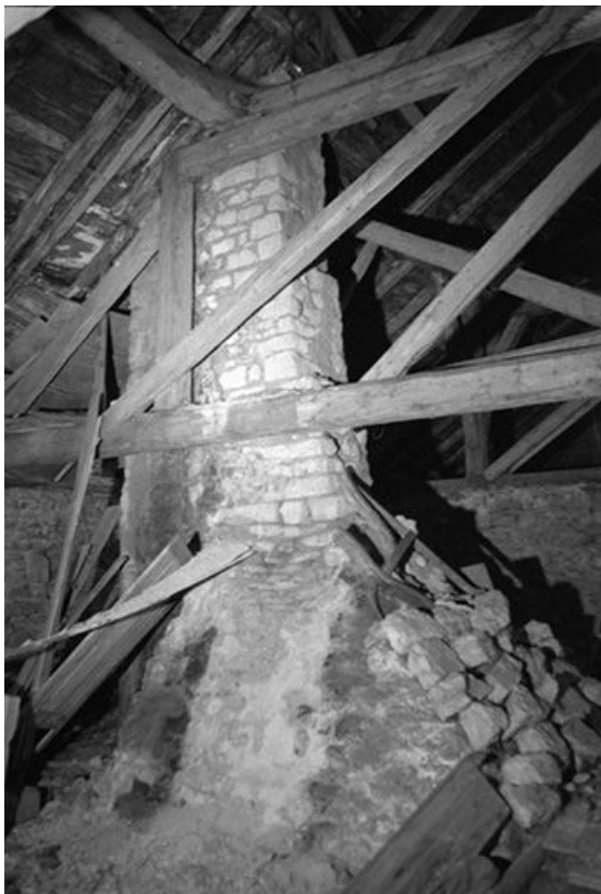
Intérieur : charpente et cheminée.
