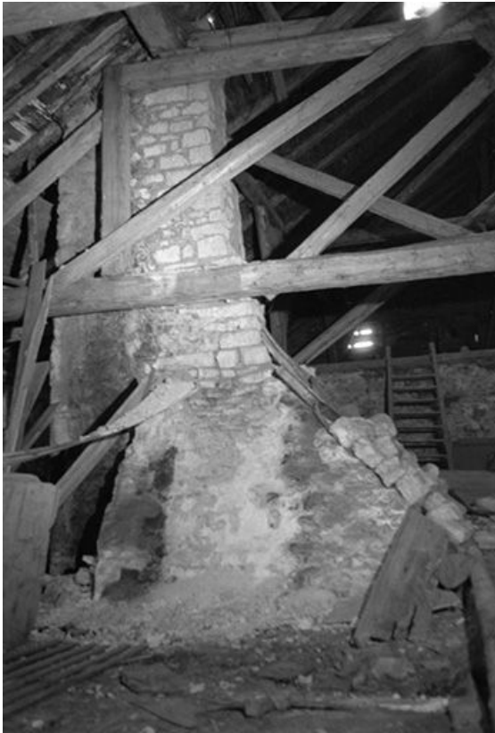
Intérieur : charpente et cheminée.
