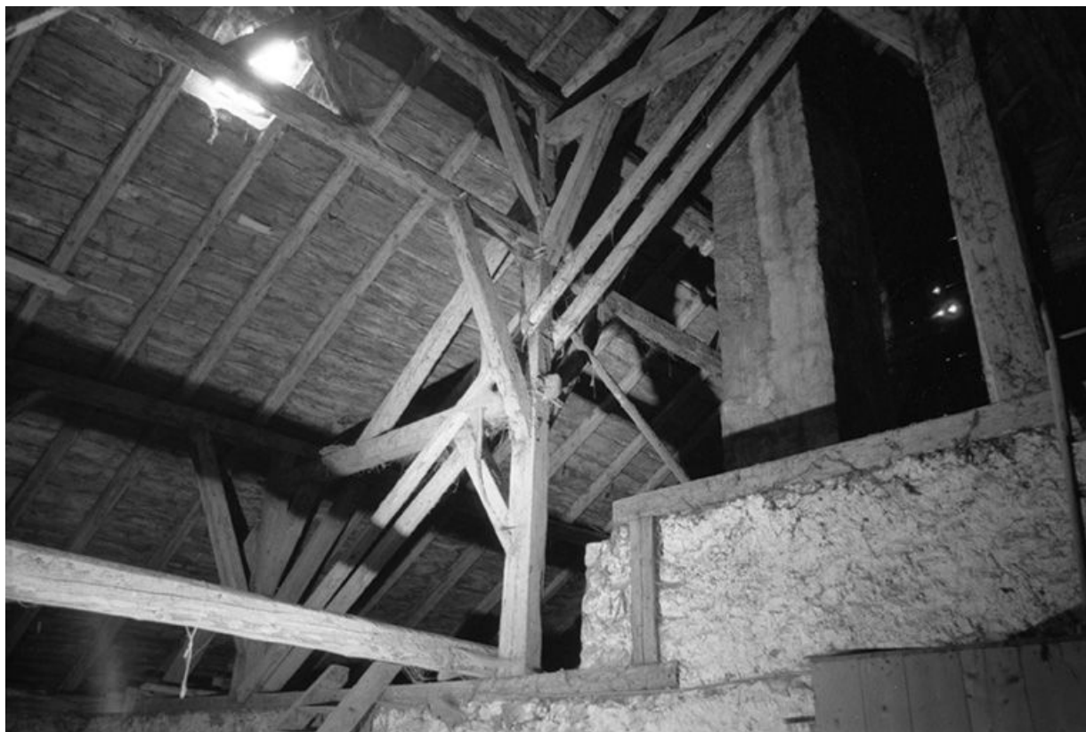
Intérieur : charpente et cheminée.
