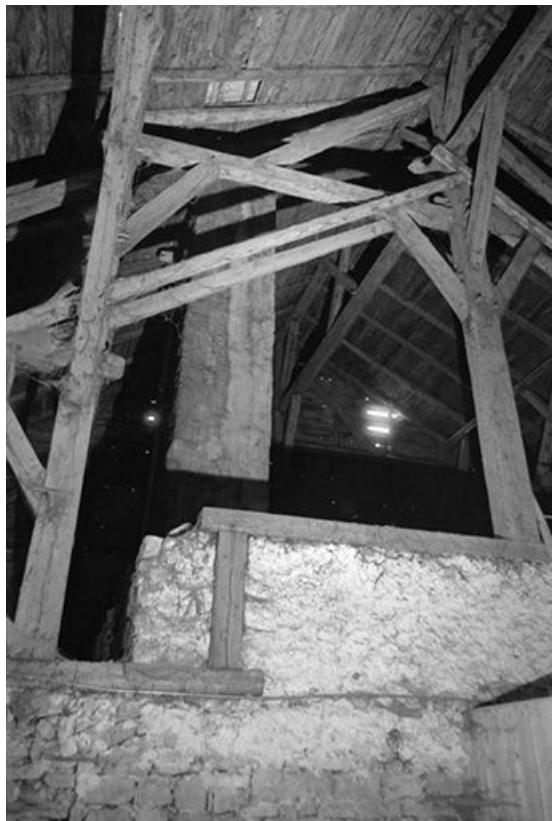
Intérieur : charpente et cheminée.
