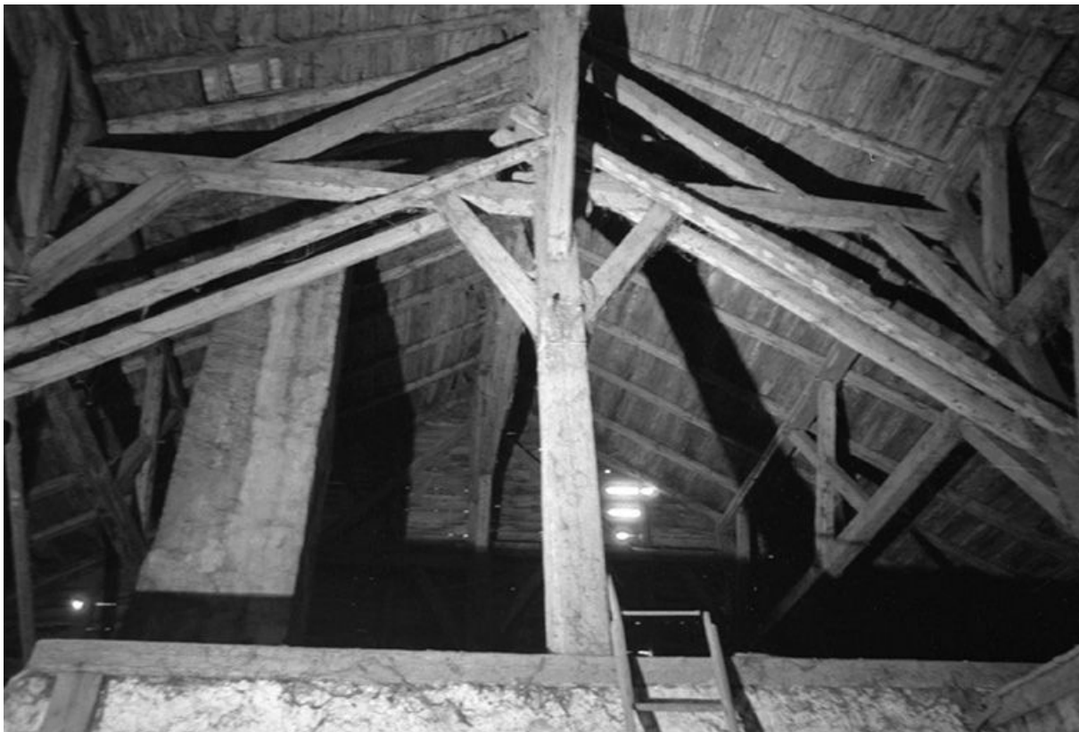
Intérieur : charpente et cheminée.
