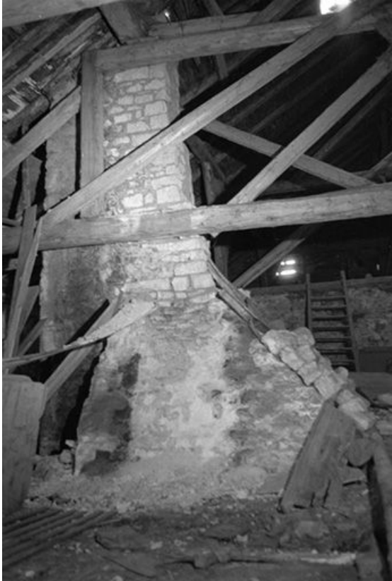
Intérieur : charpente et cheminée.
