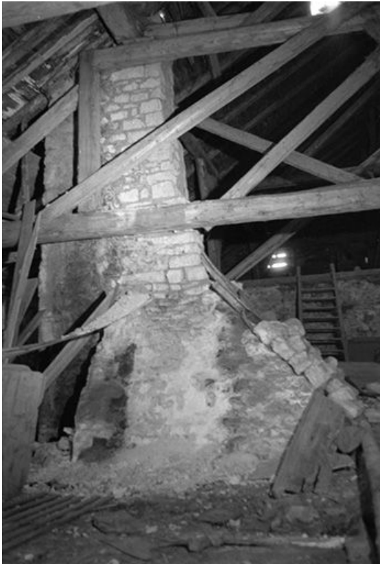
Intérieur : charpente et cheminée.
