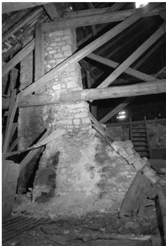
Intérieur : charpente et cheminée.
