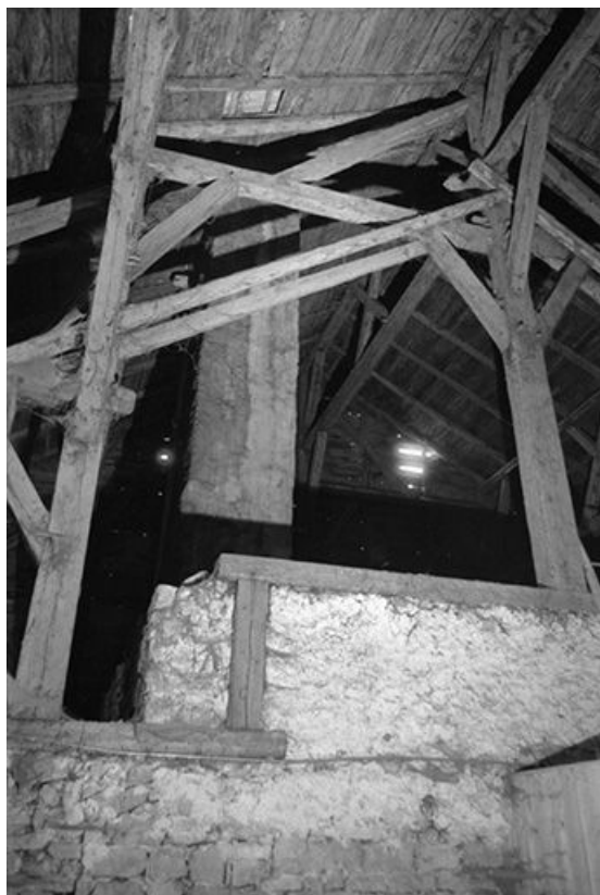
Intérieur : charpente et cheminée.
