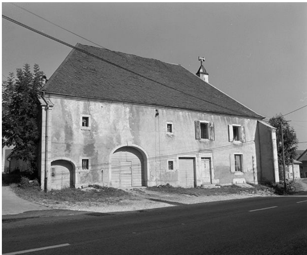
Façade antérieure, de trois quarts gauche. 25, Chaux-Neuve, 7 rue de la Grande Fontaine
