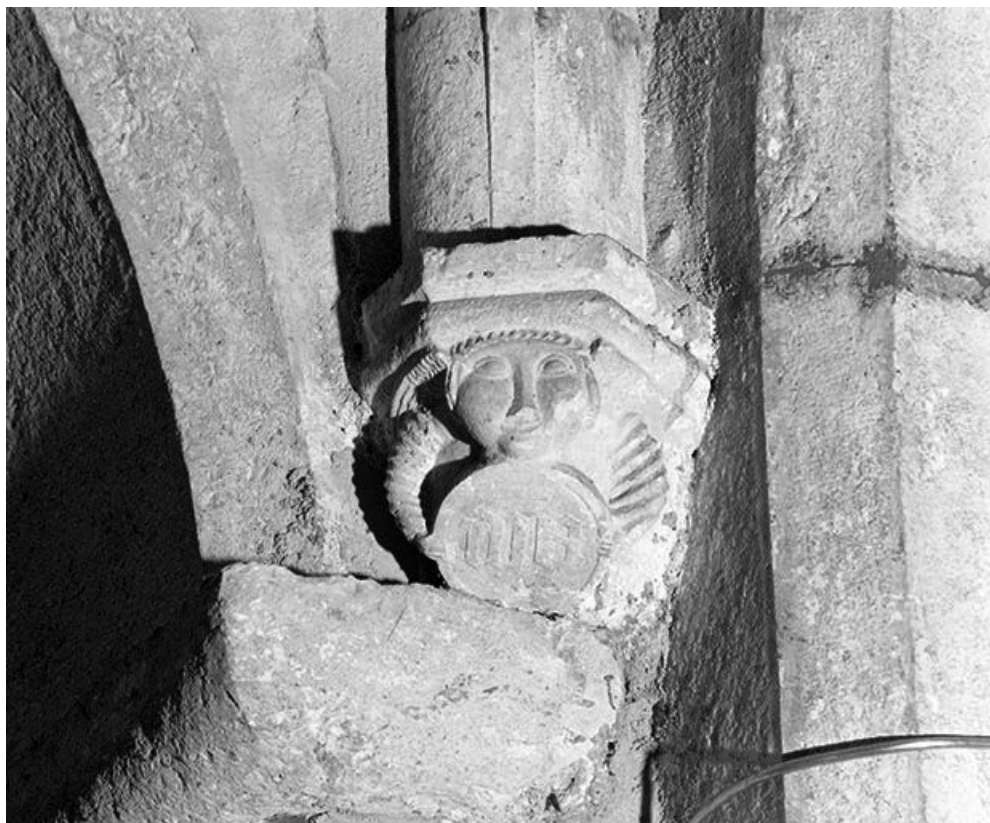
Culot, vaisseau droit de la nef, 4e travée (?). 25, Chaux-Neuve
