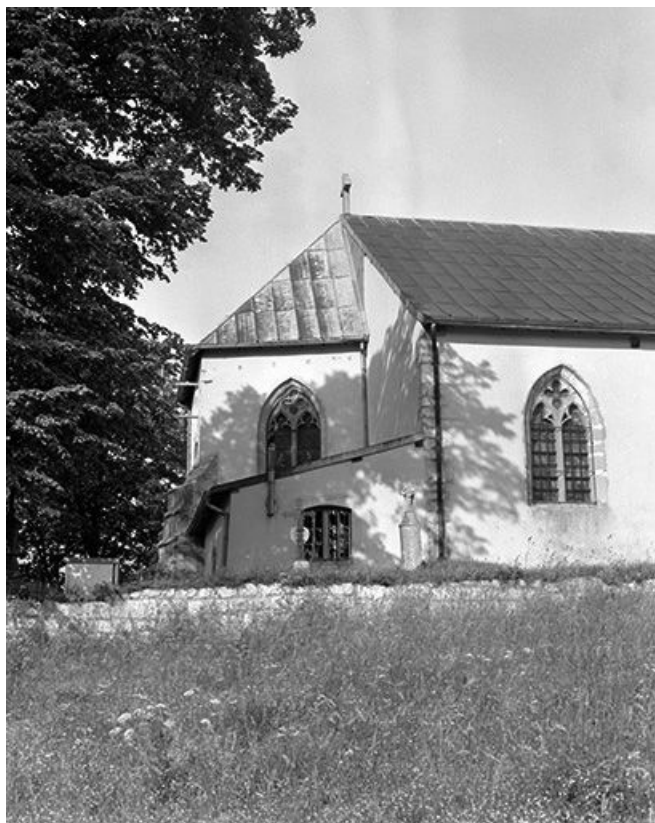
Façade latérale gauche du choeur. 25, Chaux-Neuve
