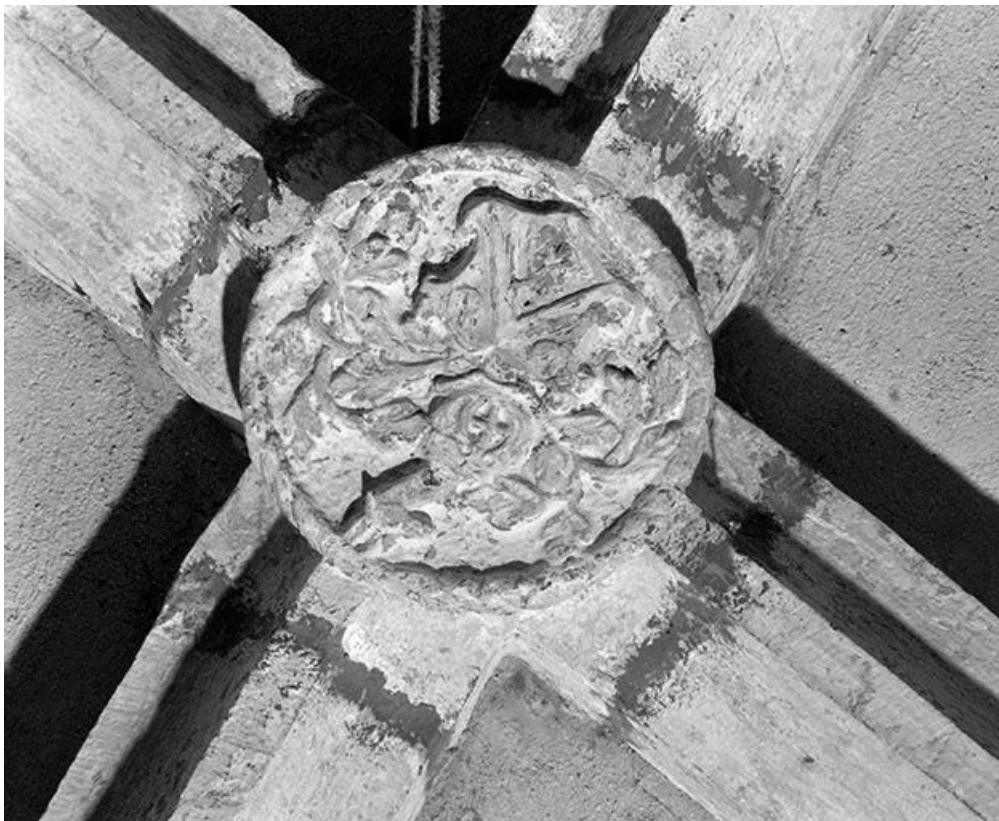
Clef de voûte du chœur. 25, Chaux-Neuve
