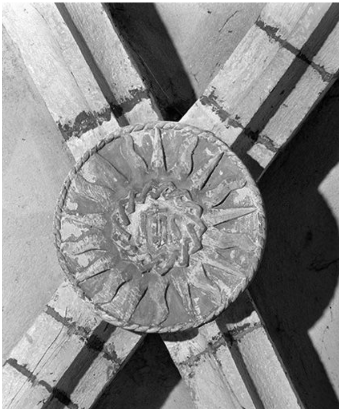
Clef de voûte, vaisseau gauche de la nef, 2e travée. 25, Chaux-Neuve
