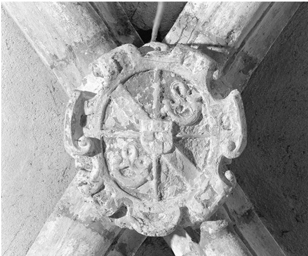
Clef de voûte du chœur. 25, Chaux-Neuve
