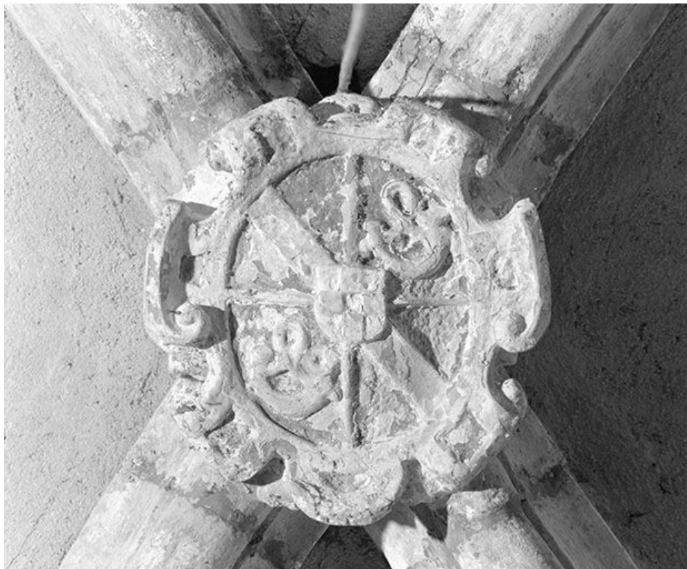
Clef de voûte du chœur. 25, Chaux-Neuve
