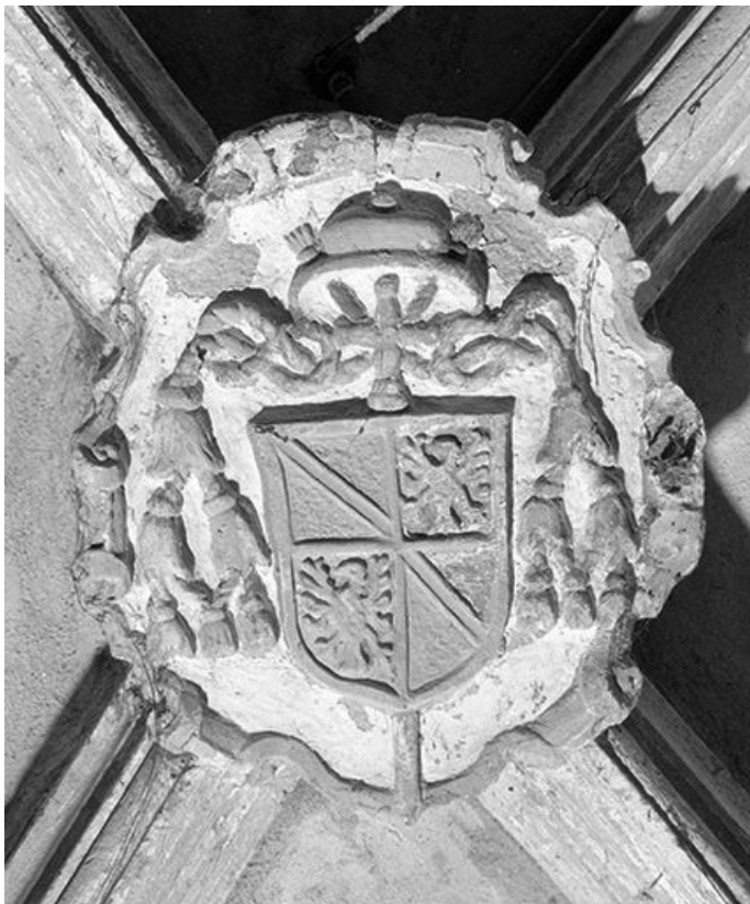
Clef de voûte, vaisseau gauche de la nef, 3e travée, aux armes de l'archevêque Ferdinand de Rye. 25, Chaux-Neuve
