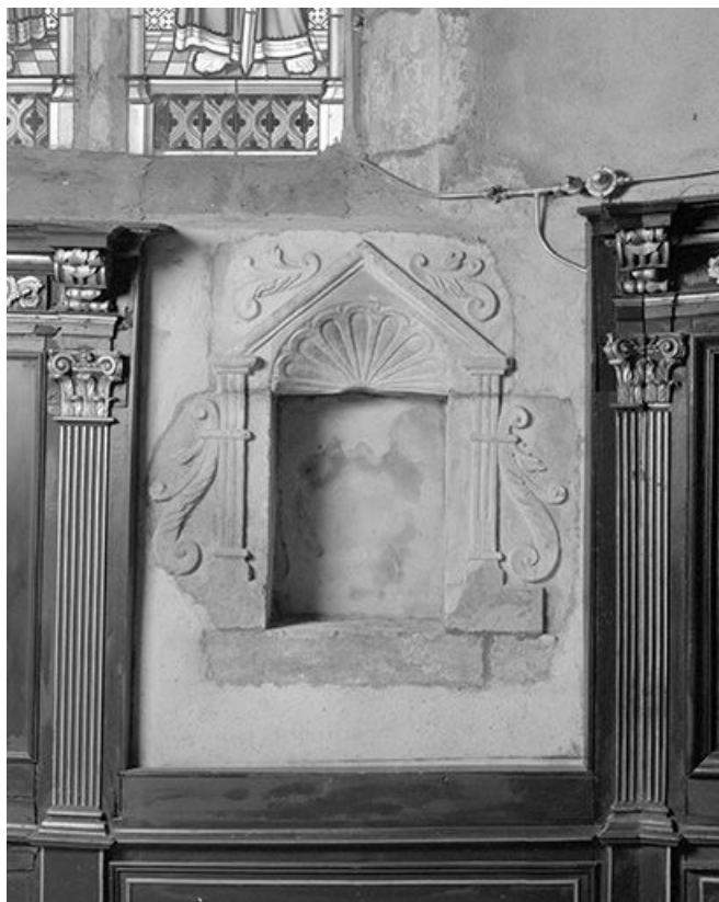
Niche du choeur. 25, Chaux-Neuve
