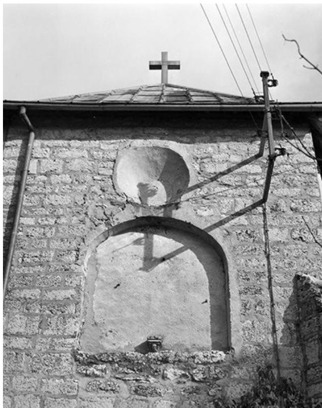
Baies murées du chevet.
