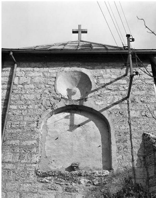
Baies murées du chevet.
