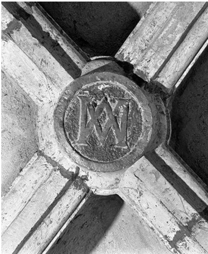
Clef de voûte, vaisseau droit de la nef, 1ère travée. 25, Chaux-Neuve
