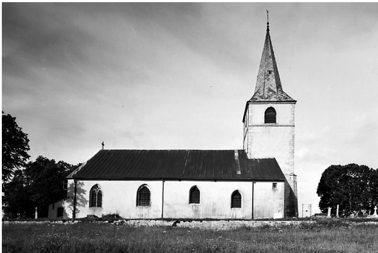
Façade latérale gauche. 25, Chaux-Neuve
