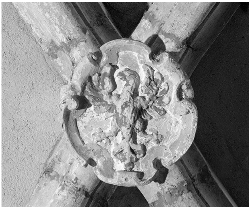
Clef de voûte du vaisseau gauche, 3e travée. 25, Chaux-Neuve
