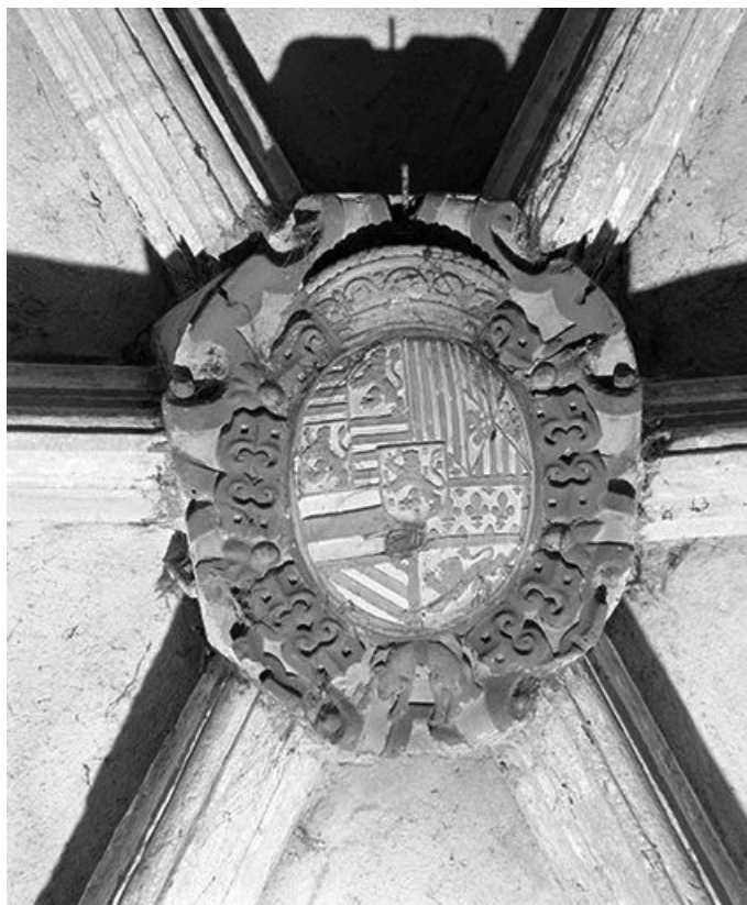
Clef de voûte du chœur.
