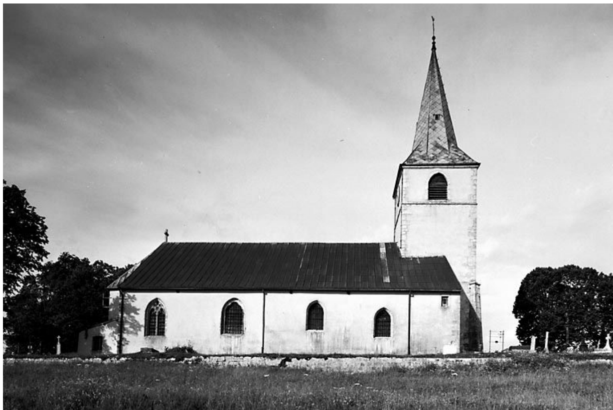
Façade latérale gauche. 25, Chaux-Neuve
