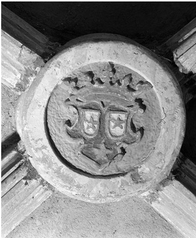
Clef de voûte du vaisseau gauche, 3e travée. 25, Chaux-Neuve
