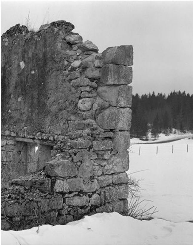
Ruine d'une ferme située au lieudit Les Cerclevaux : la chaîne d'angle et lemur. 25, Chaux-Neuve
