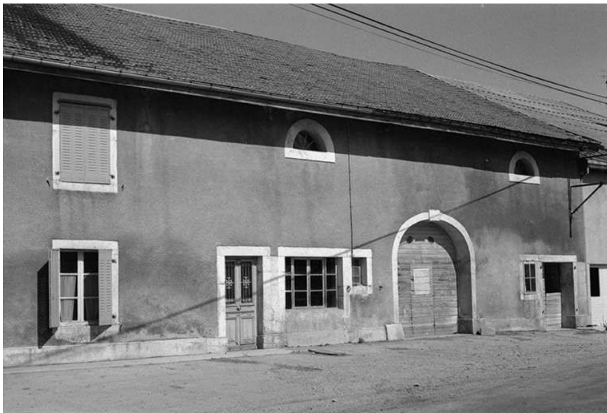
Ferme datée de 1902, située Grande Rue, cadastrée 1967 AB 23 : façade antérieure. 25, Chaux-Neuve
