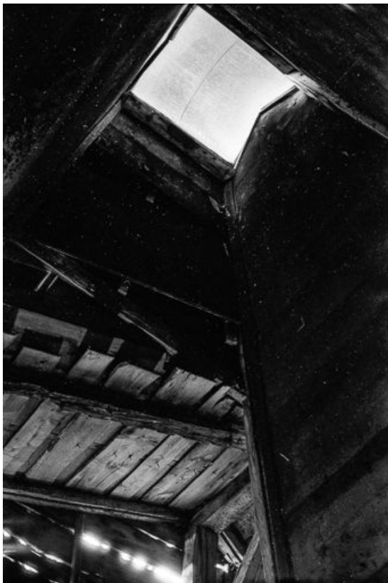
Ferme de 1750, située au lieudit Le Pré Poncez : "tué" vu de l'intérieur. 25, Chaux-Neuve
