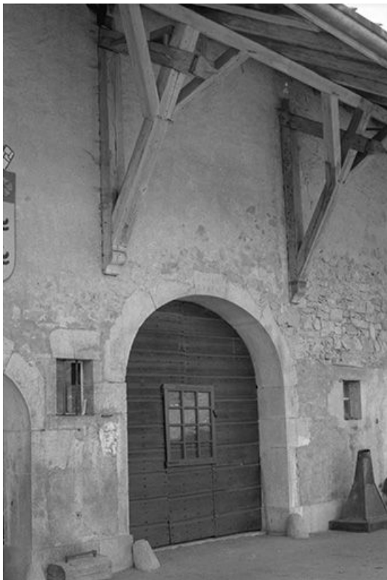
Ferme de 1818, située 11 Grande Rue : porte de grange et débord du toit. 25, Chaux-Neuve
