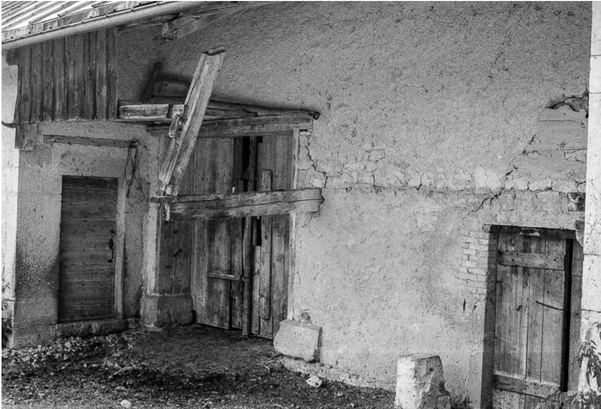
Ferme située au lieudit Le Pré Poncet : le débord du toit. 25, Chaux-Neuve
