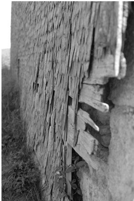
Ferme datée de 1870, située 5 rue de la Grande Fontaine : tavaillons sur le pignon gauche. 25, Chaux-Neuve
