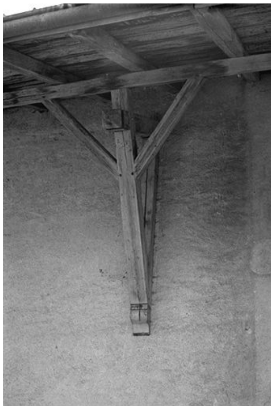
Ferme de 1818, située 11 Grande Rue : extrémité de la pièce de bois doublant le chevron-arbalétrier. 25, Chaux-Neuve
