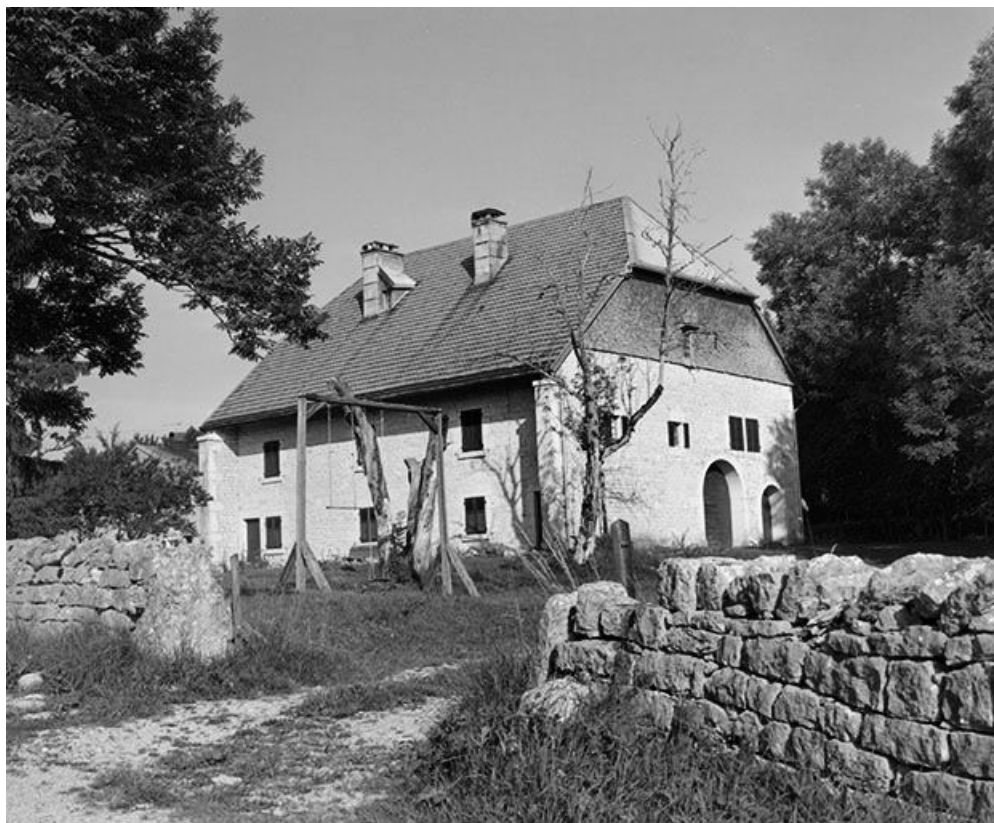
Façades antérieure et latérale droite et mur d'enclos.
