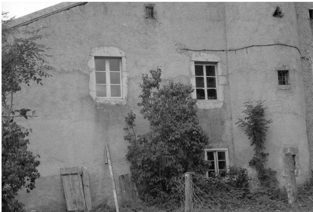
Détail de la façade latérale droite avec la tourelle.
