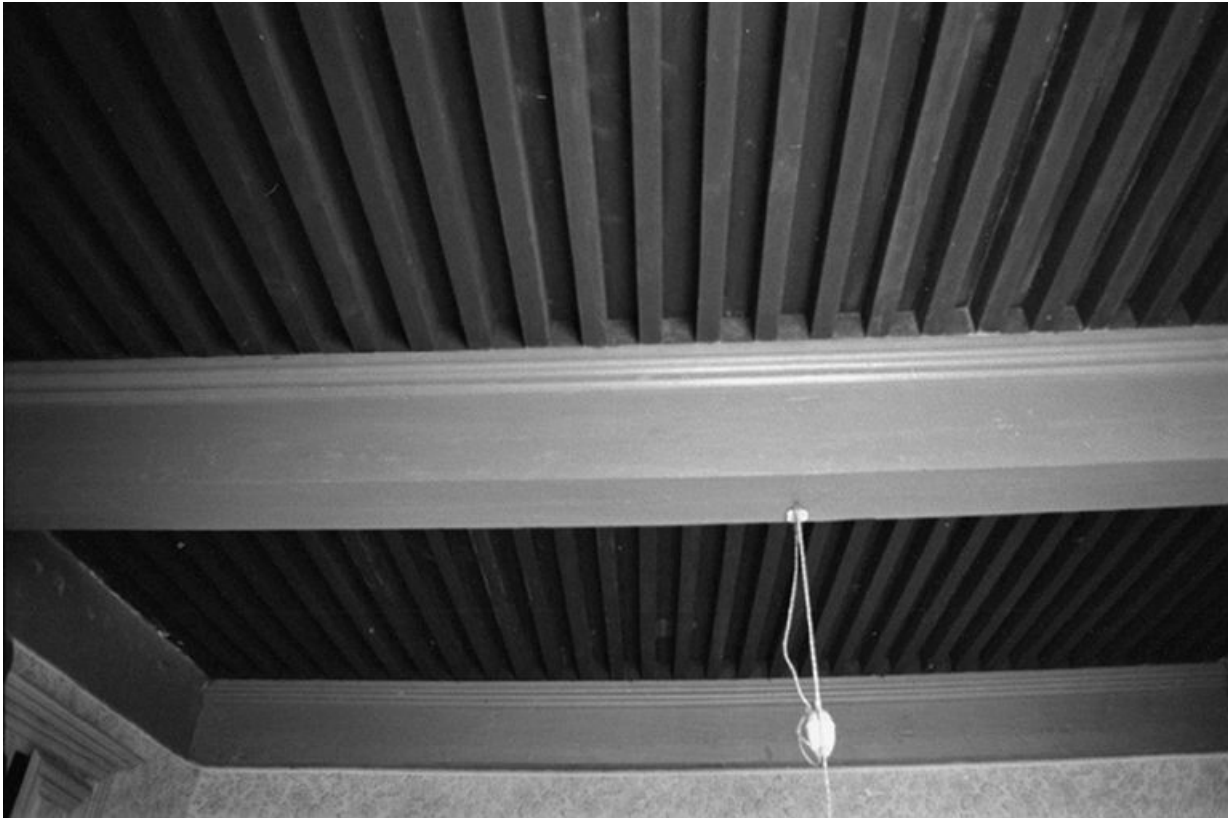
Intérieur : plafond de la cuisine. 25, Châtelblanc Grande Rue
