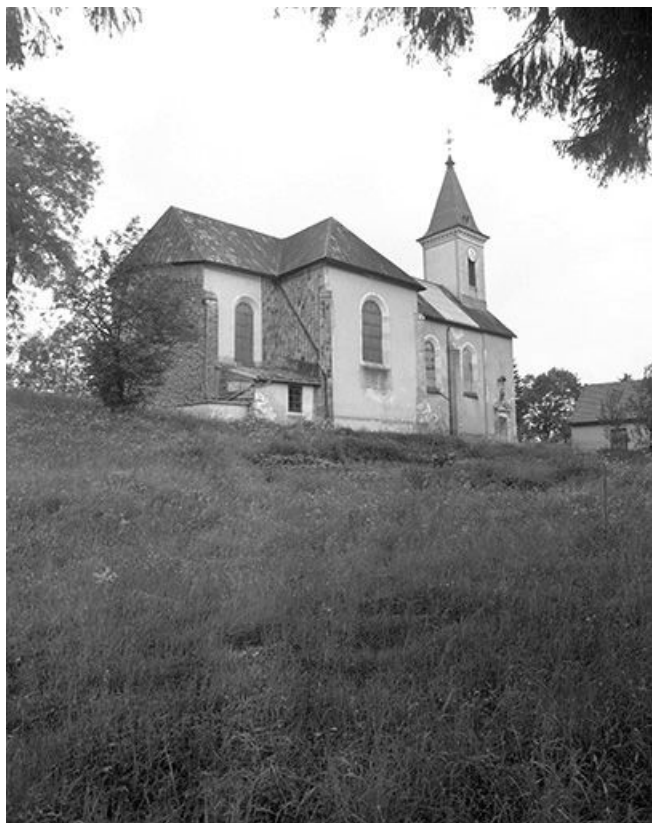
Façade latérale droite.
