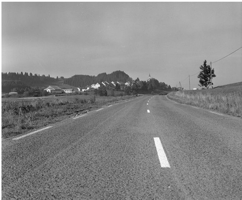
Vue d'ensemble du village, depuis la route de Chaux-Neuve. 25, Châtelblanc
