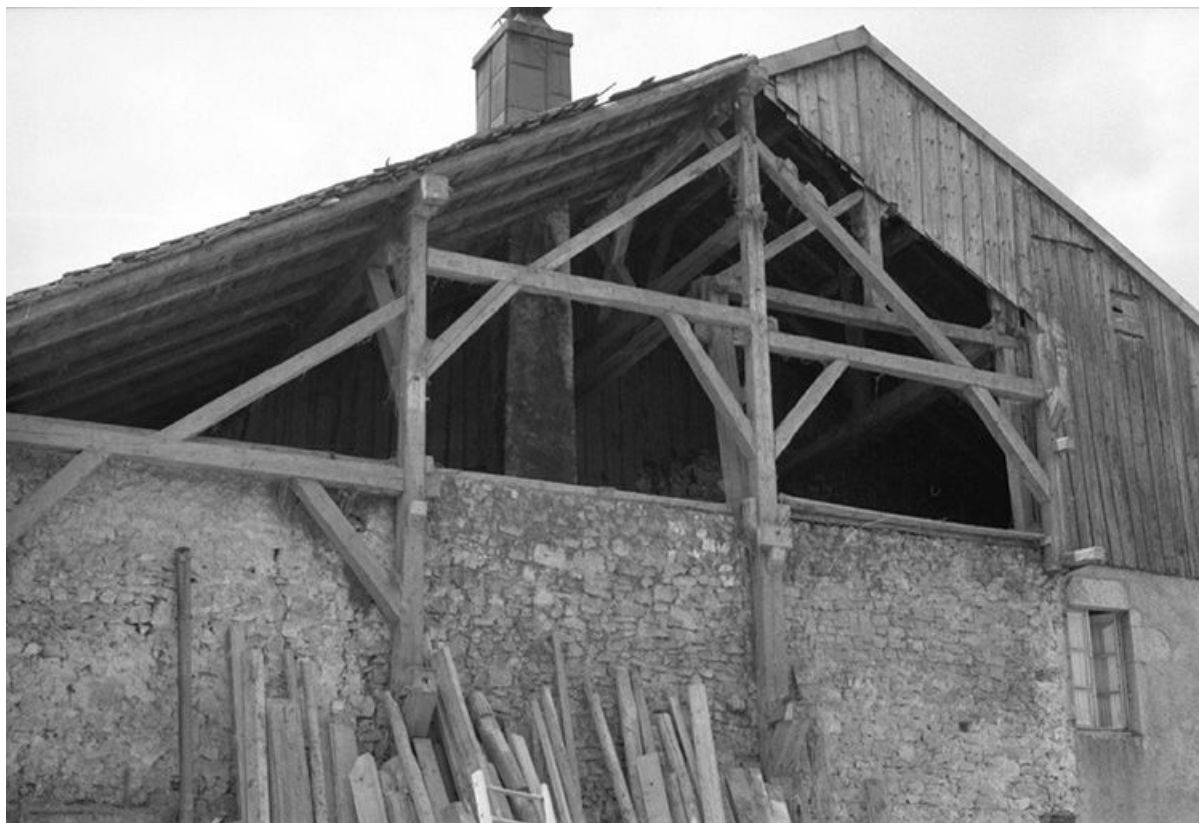
Ferme datée de 1786 située Grande Rue, cadastrée 1972 AB 30 : façade latérale gauche. 25, Châtelblanc
