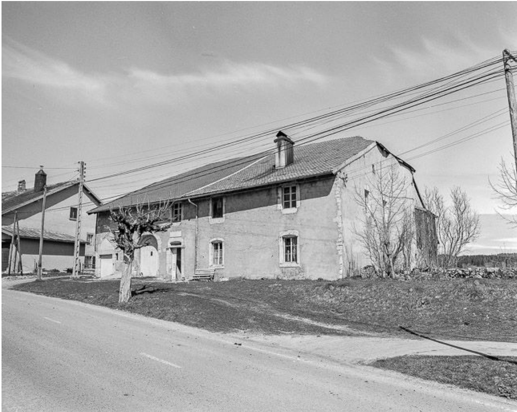
Façades antérieure et latérale droite.
