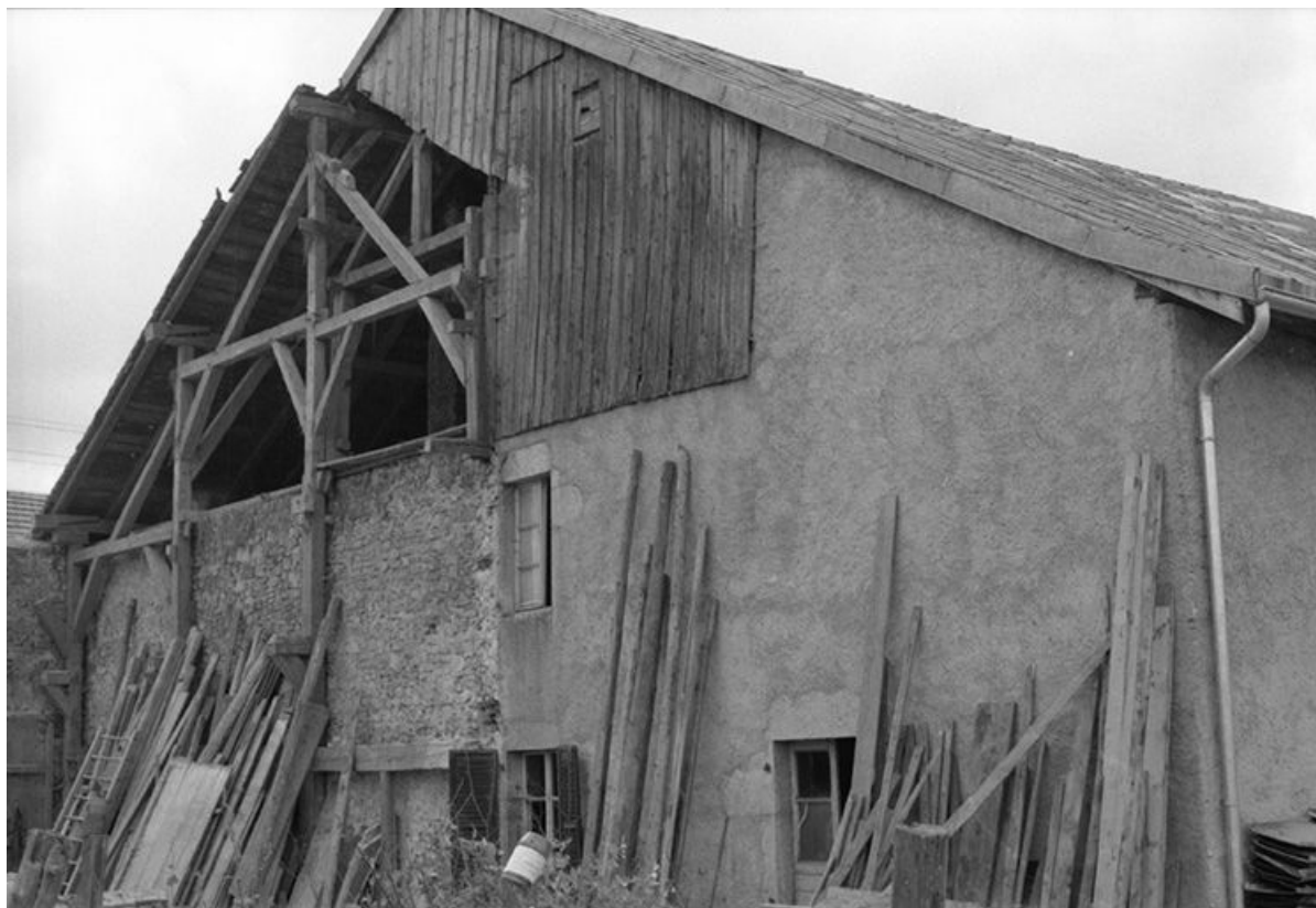
Ferme datée de 1786 située Grande Rue, cadastrée 1972 AB 30 : façade latérale gauche. 25, Châtelblanc
