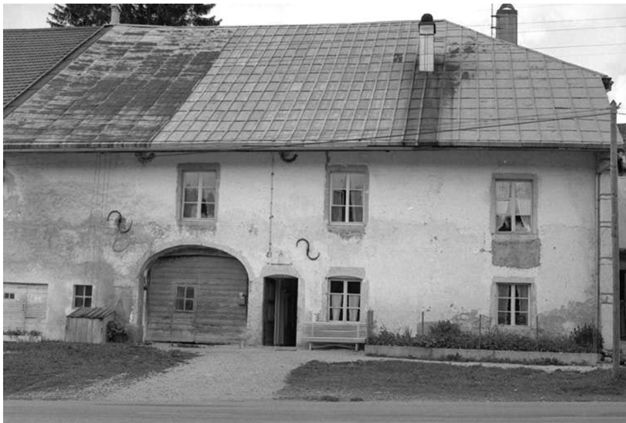
Ferme datée de 1754, située Grande Rue, cadastrée 1972 AB 18 : façade antérieure. 25, Châtelblanc
