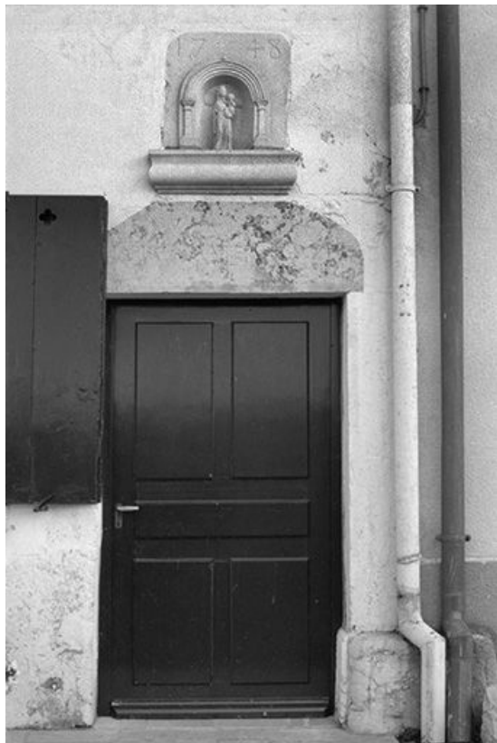
Ferme datée de 1748, située rue du Chalet, cadastrée 1972 AB 63 : porte d'entrée. 25, Châtelblanc
