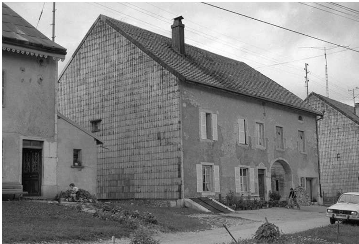
Ferme datée de 1877, située chemin de la Combille : façades antérieure et latérale gauche. 25, Châtelblanc
