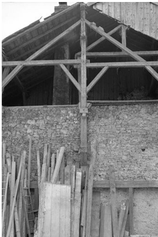
Ferme datée de 1786 située Grande Rue, cadastrée 1972 AB 30 : façade latérale gauche. 25, Châtelblanc
