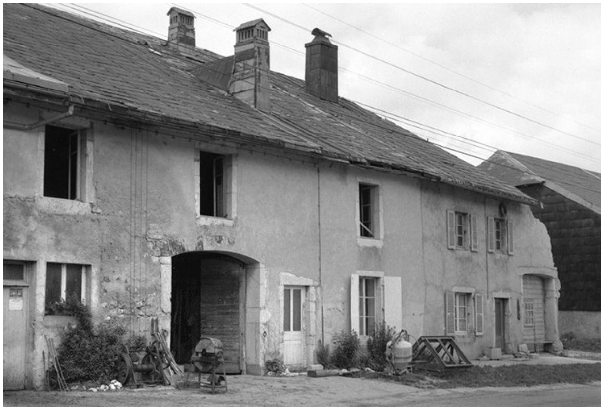
Ferme datée de 1786 située Grande Rue, cadastrée 1972 AB 30 : façade antérieure. 25, Châtelblanc
