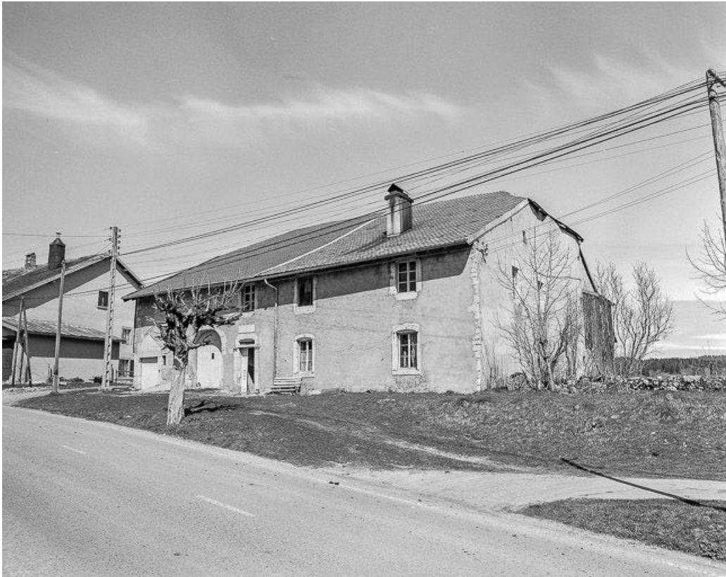
Façades antérieure et latérale droite.
