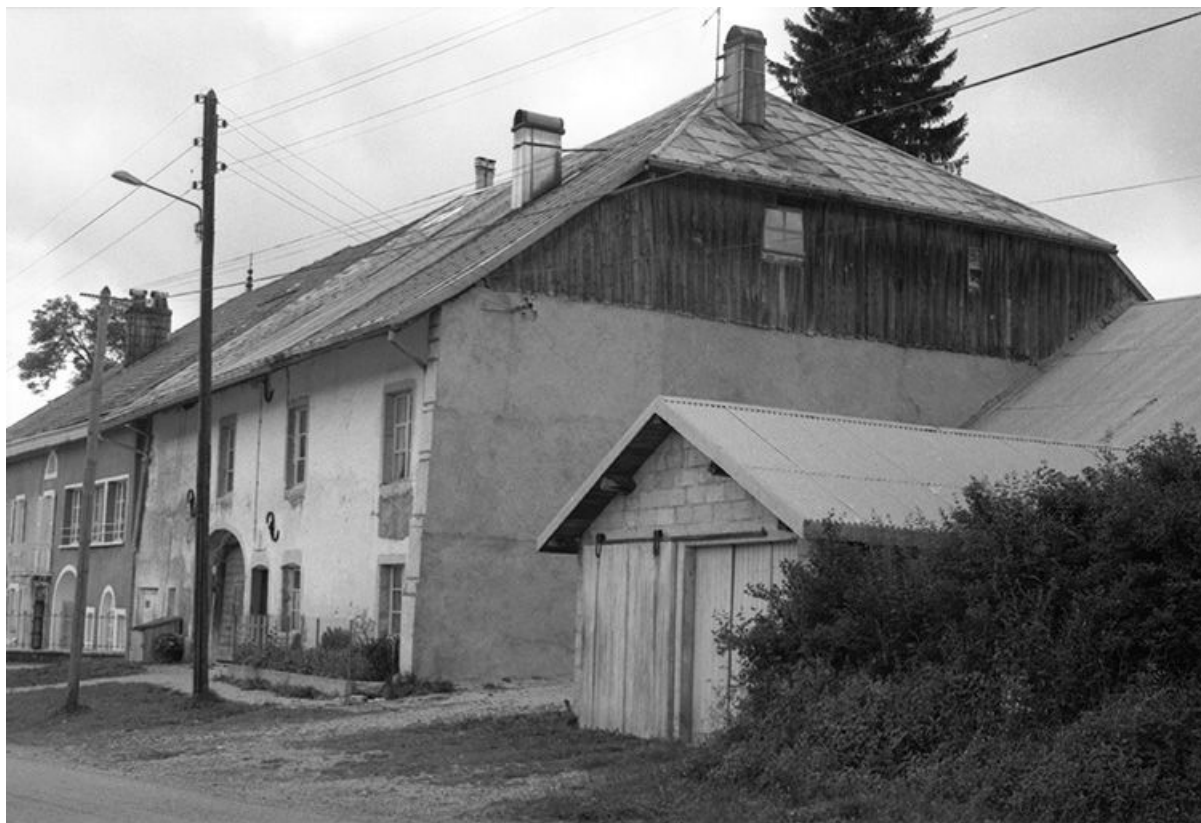
Ferme datée de 1754, située Grande Rue, cadastrée 1972 AB 18 : façade latérale droite. 25, Châtelblanc
