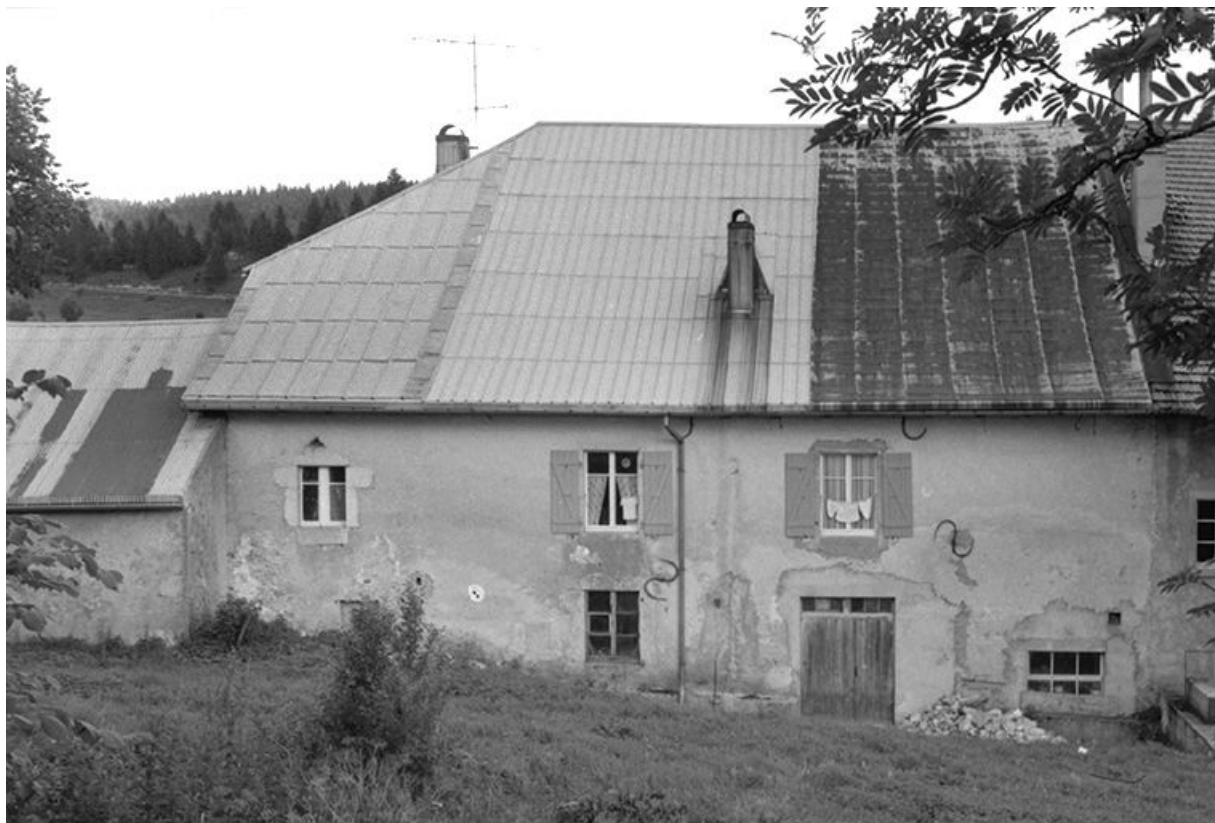
Ferme datée de 1754, située Grande Rue, cadastrée 1972 AB 18 : façade postérieure. 25, Châtelblanc
