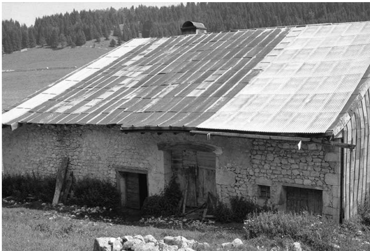
Façade postérieure, porte de grange, écuries. 25, Chapelle-des-Bois, lieudit : la Combe des Cives
