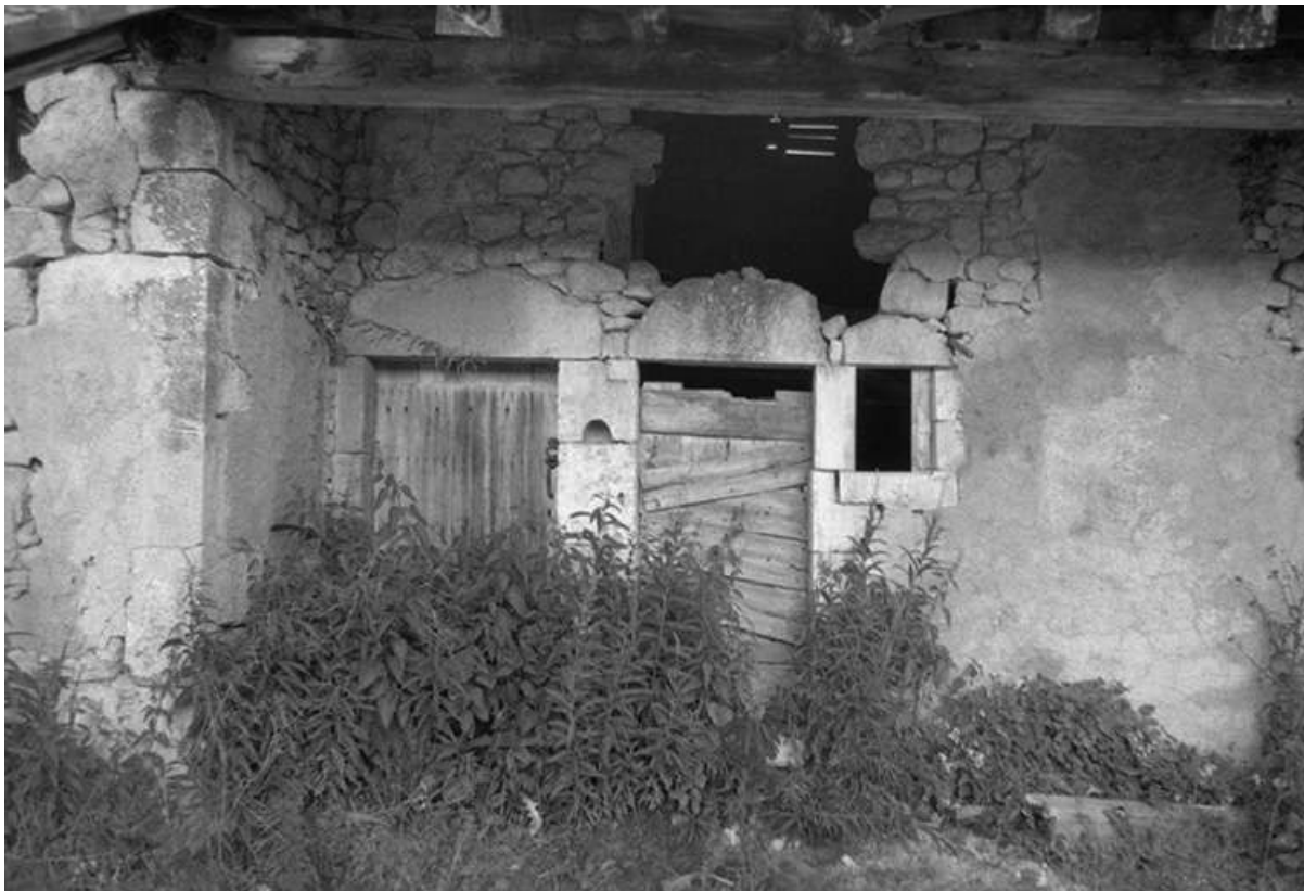
Porte d'entrée du couloir, porte d'entrée d'habitation.
