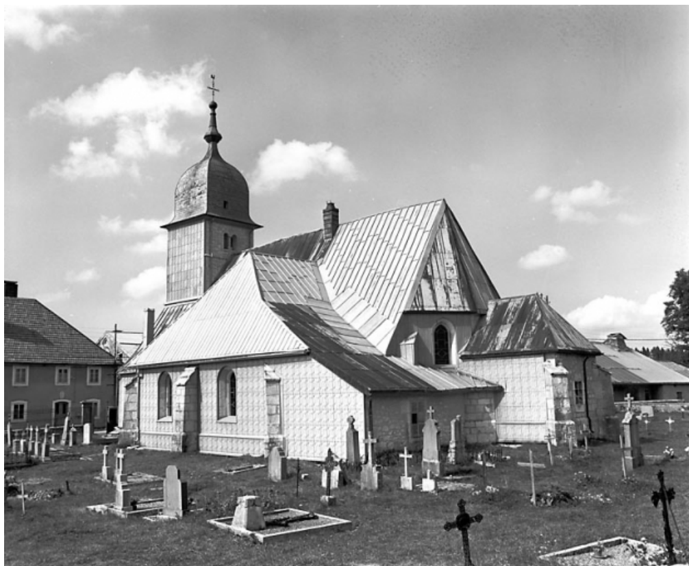
Façades postérieure et latérale droite. 25, Chapelle-des-Bois
