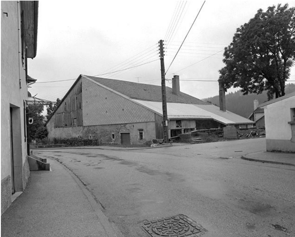
Pignon sur rue et goutterot.
