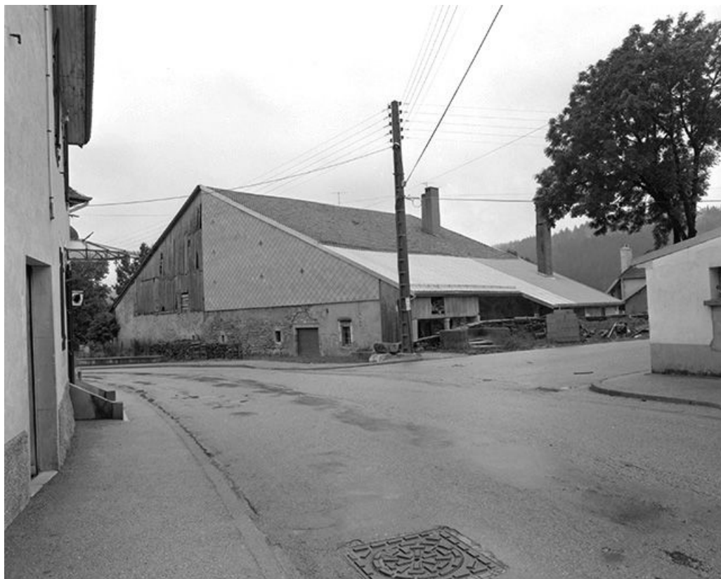
Pignon sur rue et goutterot.
