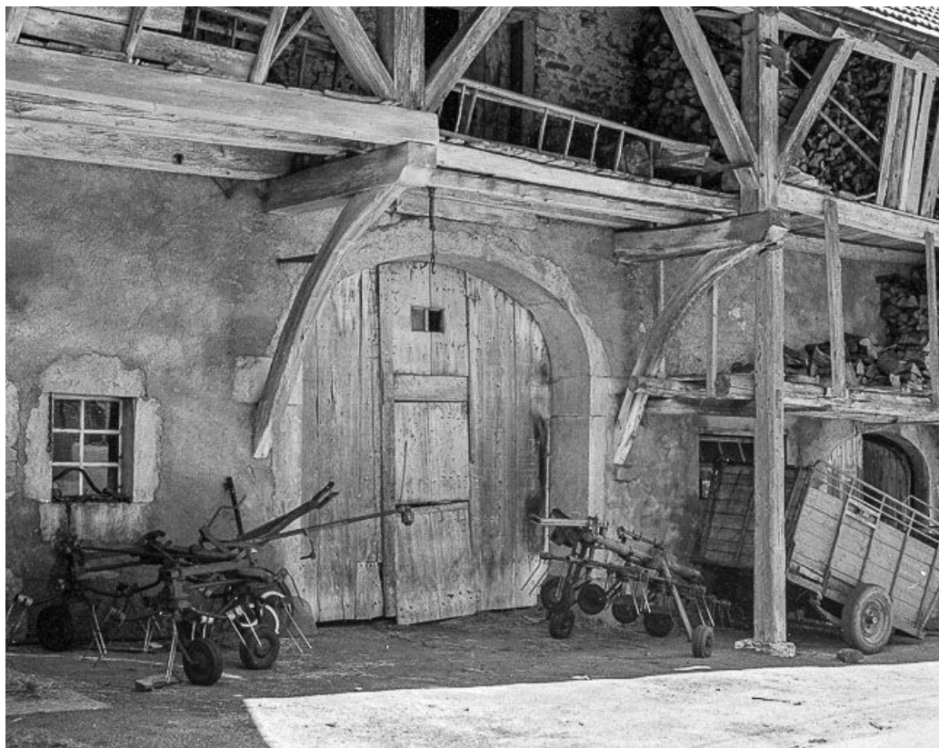
Détail du goutterot sur rue, de trois quarts.
