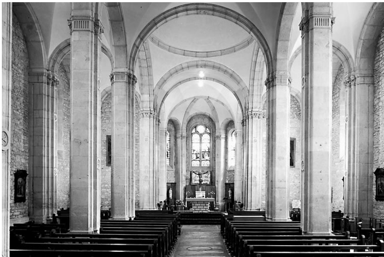
La nef et le choeur vus depuis l'entrée.
