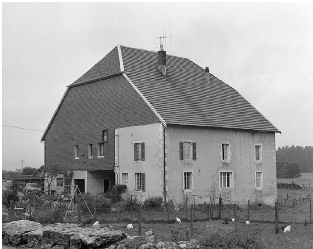
Ferme située rue du Jura, derrière l'oratoire : façades antérieure et latérale droite. 25, Bonnevaux
