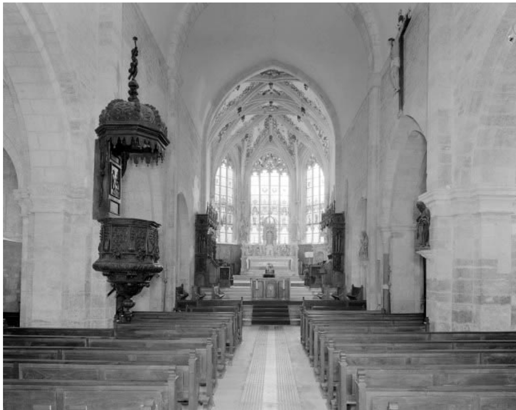
Nef et chœur de l'église, vus depuis l'entrée.
