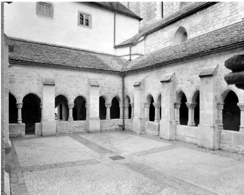
Cour intérieure du cloître.
