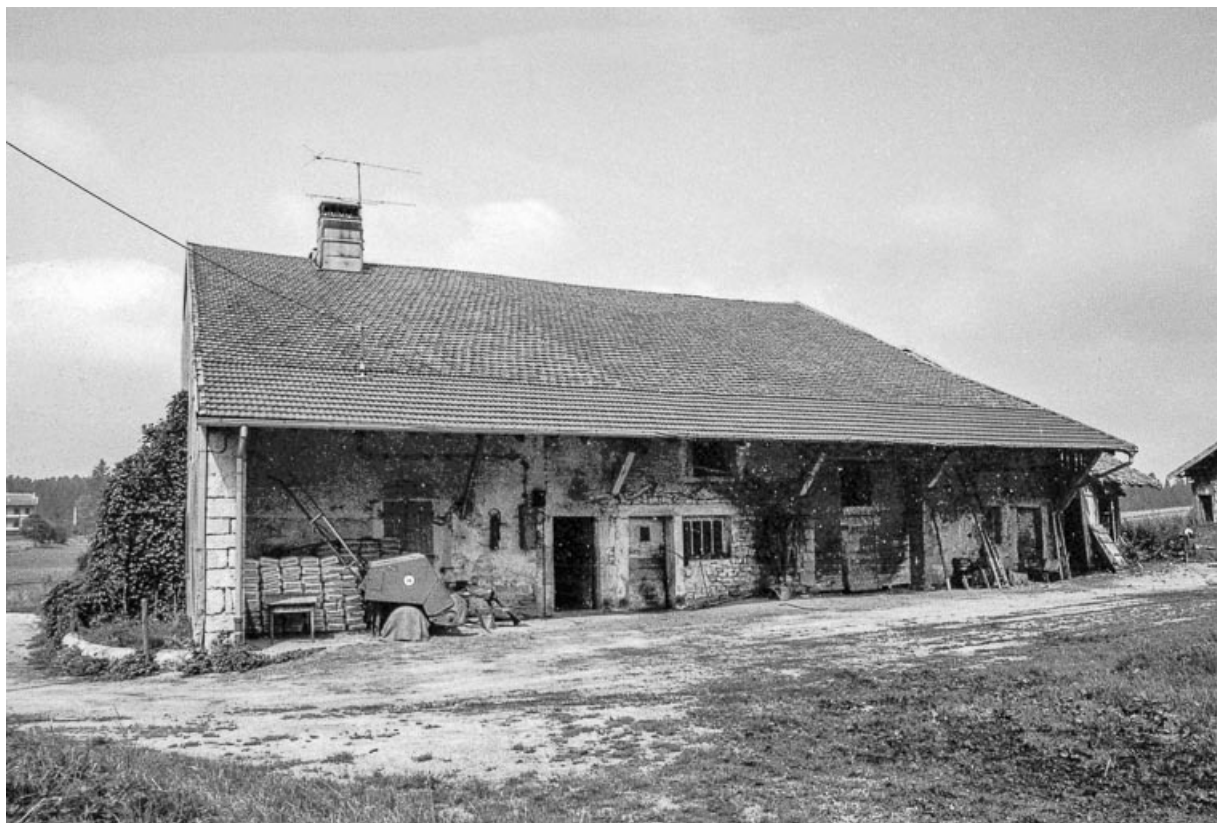
Façade latérale droite.
