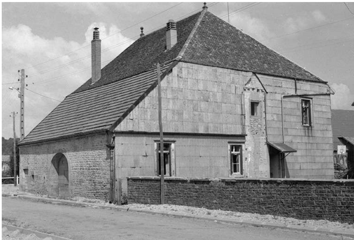
Façades postérieure et latérale droite.
