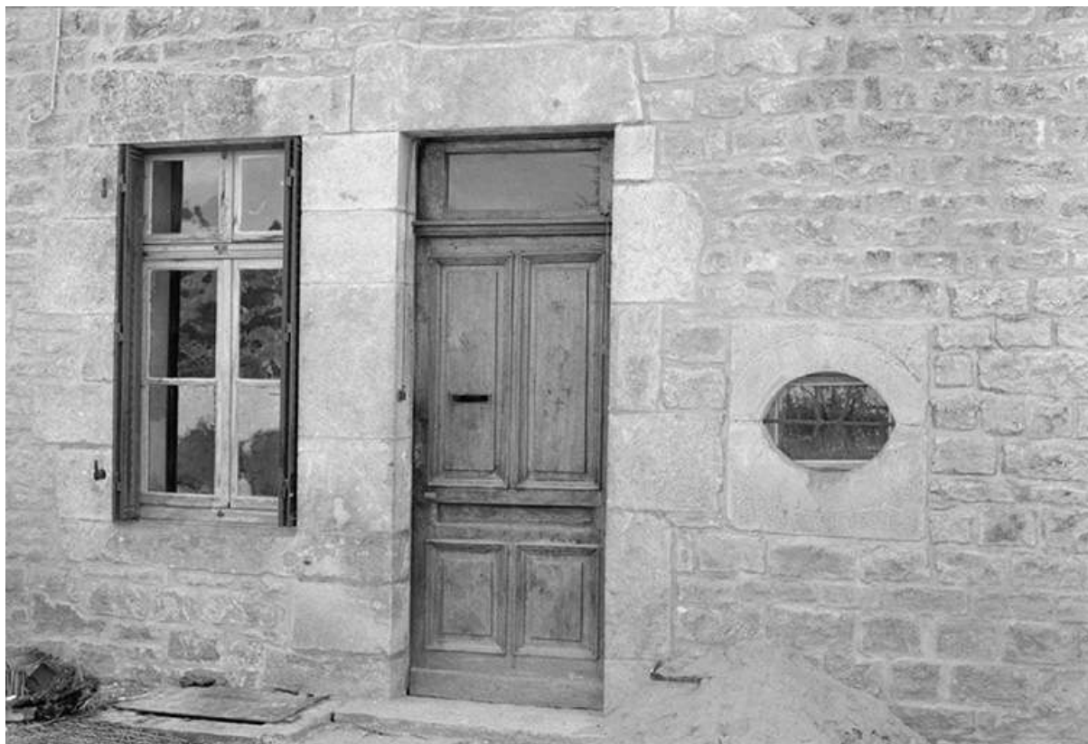
Porte d'entrée, fenêtre de la cuisine, oculus éclairant l'évier.
