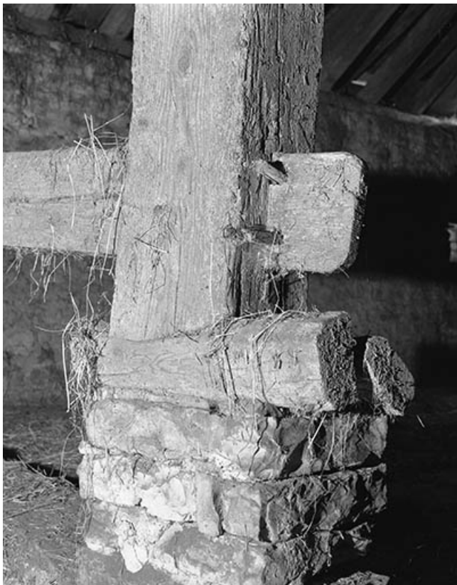
Partie inférieure d'un poteau de charpente au niveau de la partie habitation. 25, Villeneuve-d'Amont, lieudit : la Perrière
