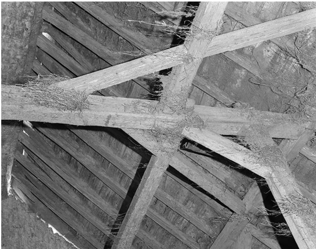
Poteau de charpente latéral d'une ferme.
