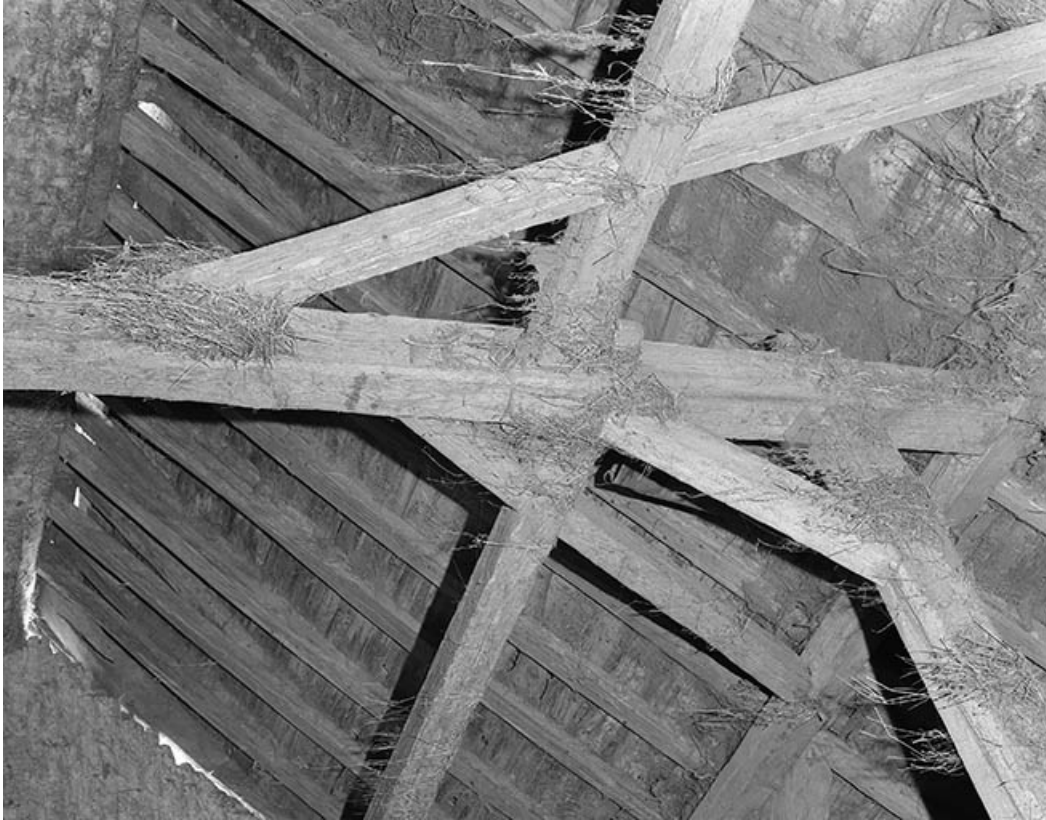
Poteau de charpente latéral d'une ferme. 25, Villeneuve-d'Amont, lieudit : la Perrière
