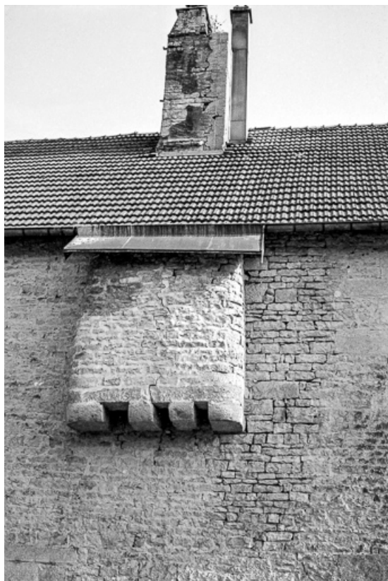
Façade postérieure : cul-du-four extérieur suspendu.
