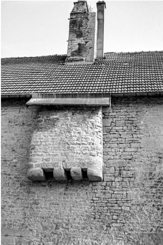
Façade postérieure : cul-du-four extérieur suspendu.
