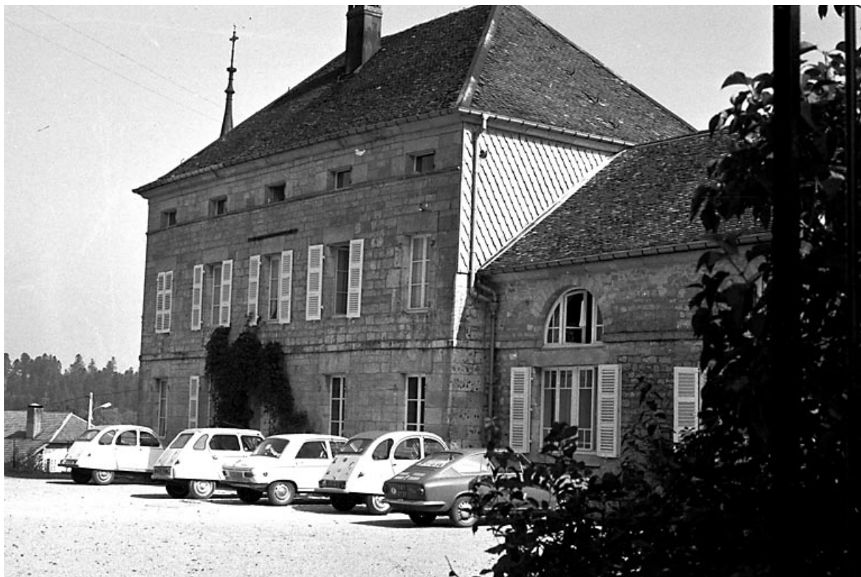
Façade sur le parc.
