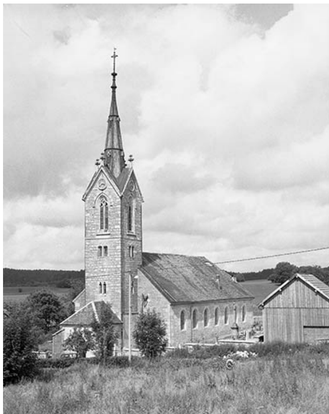
Extérieur : faces antérieure et latérale droite.
