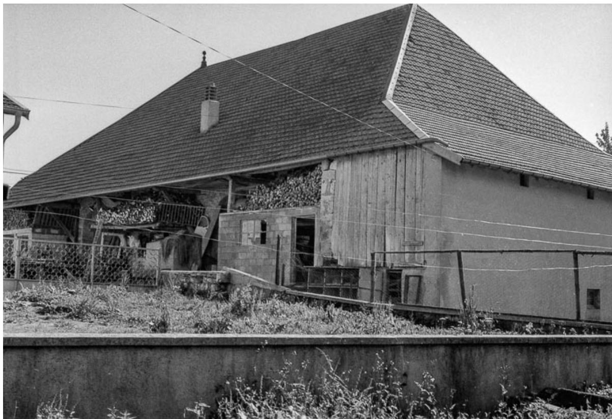
Ferme cadastrée 1961 AB 8 : façades postérieure et latérale gauche. 25, Villeneuve-d'Amont
