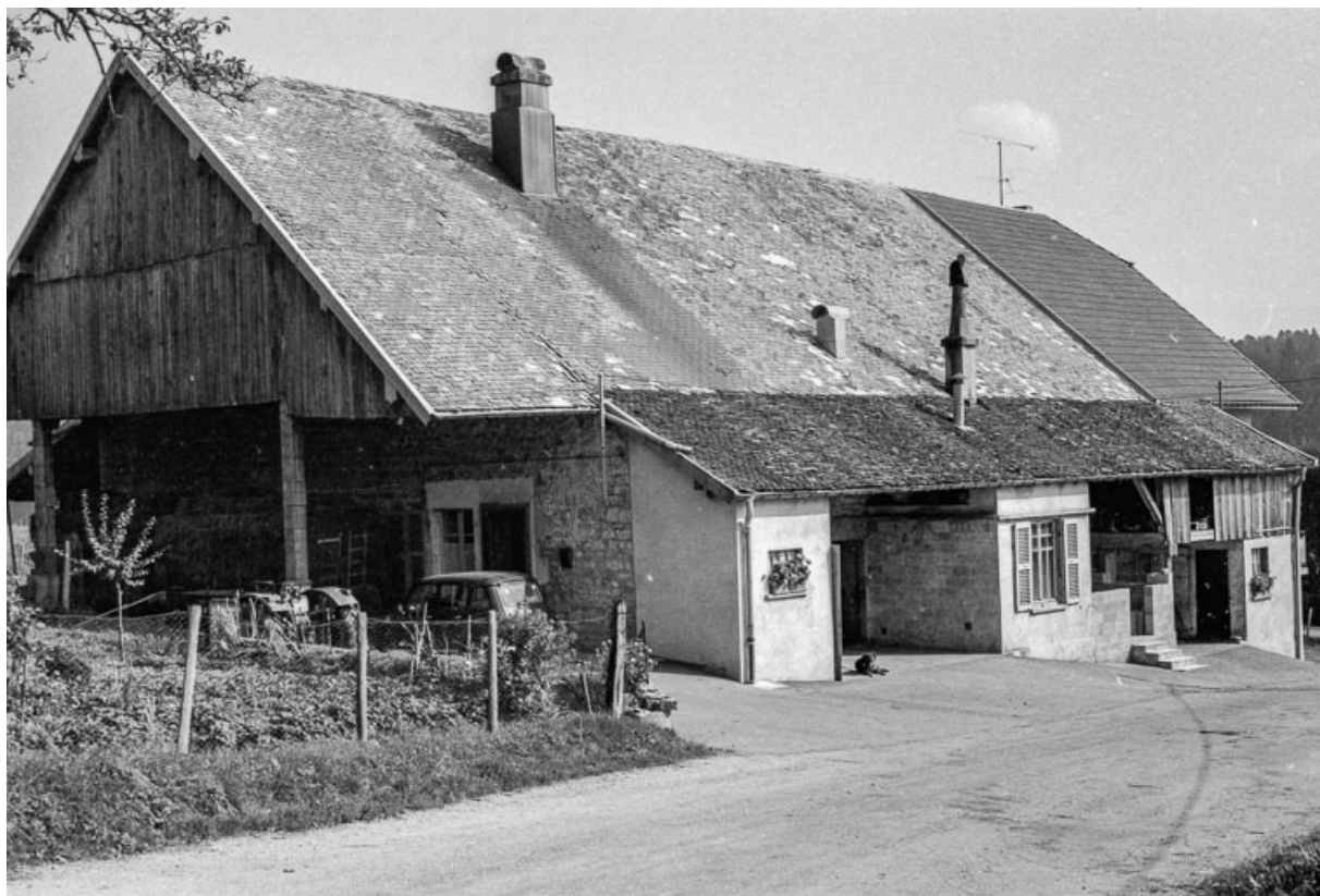
Ferme cadastrée 1961 AC 28 : façade sur rue. 25, Villeneuve-d'Amont
