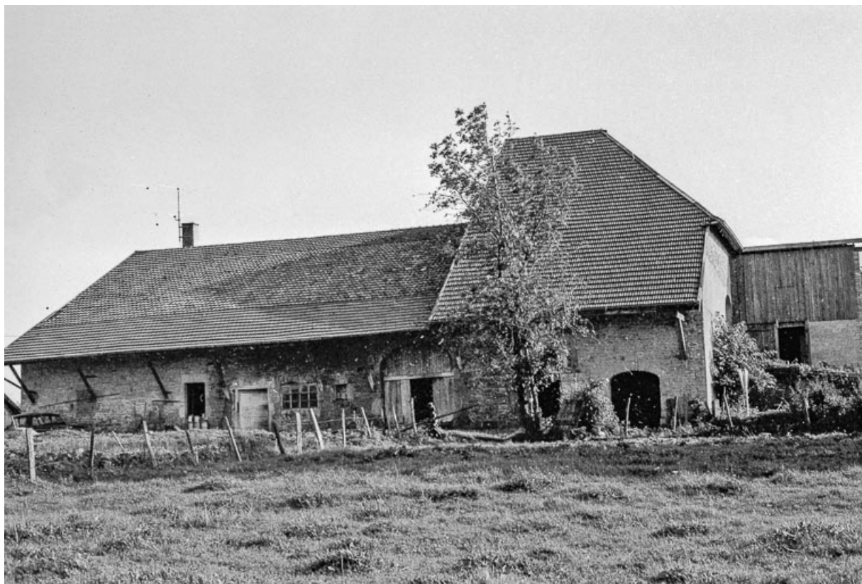
Ferme cadastrée 1961 C 27, située au lieudit Narbaud : façade antérieure. 25, Villeneuve-d'Amont
