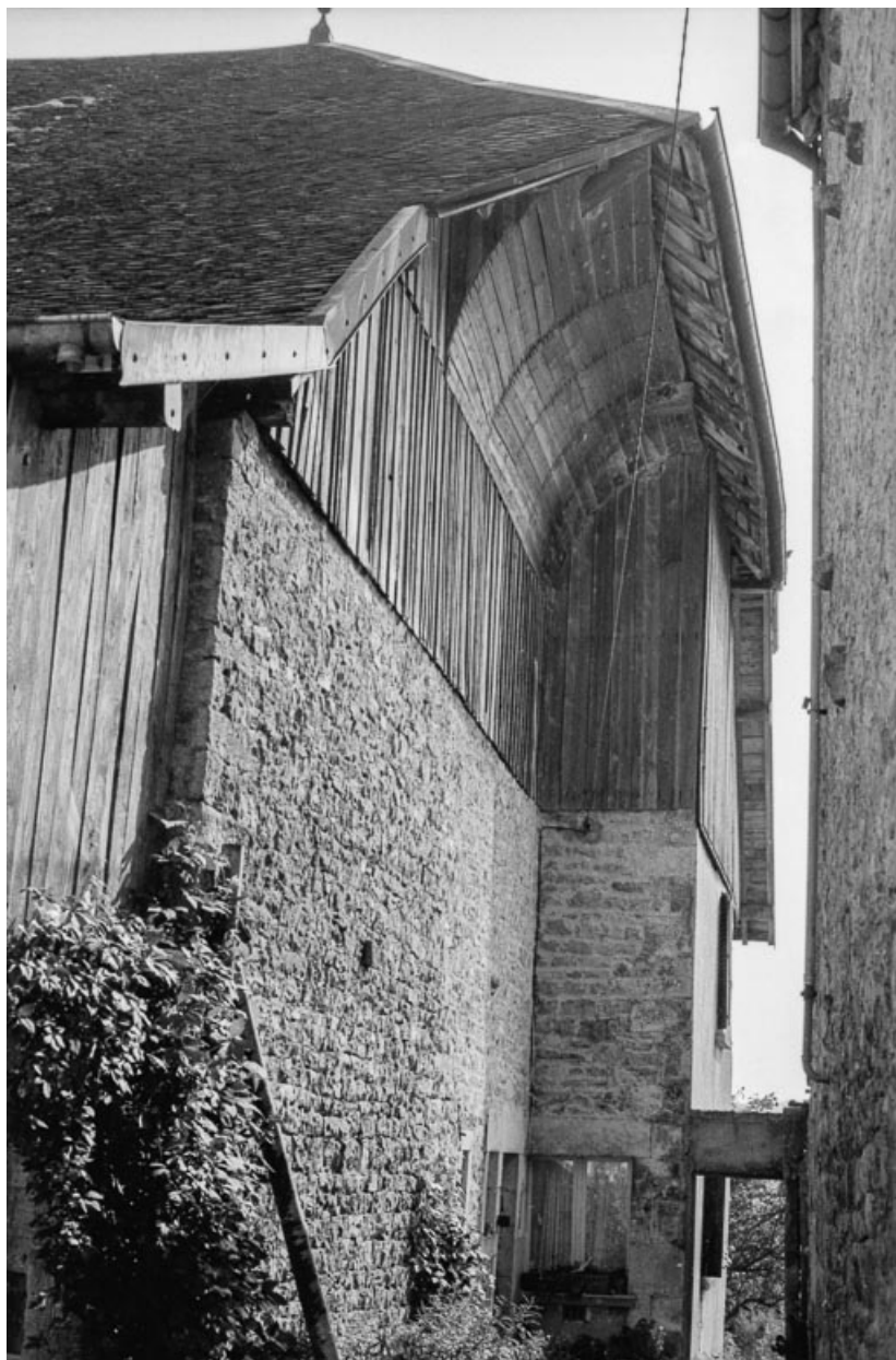
Ferme cadastrée 1961 AB 50 : façade postérieure (?). 25, Villeneuve-d'Amont
