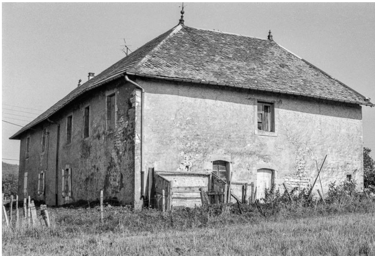
Ferme cadastrée 1961 AB 12, datée de 1771 : façades postérieure et latérale gauche. 25, Villeneuve-d'Amont
