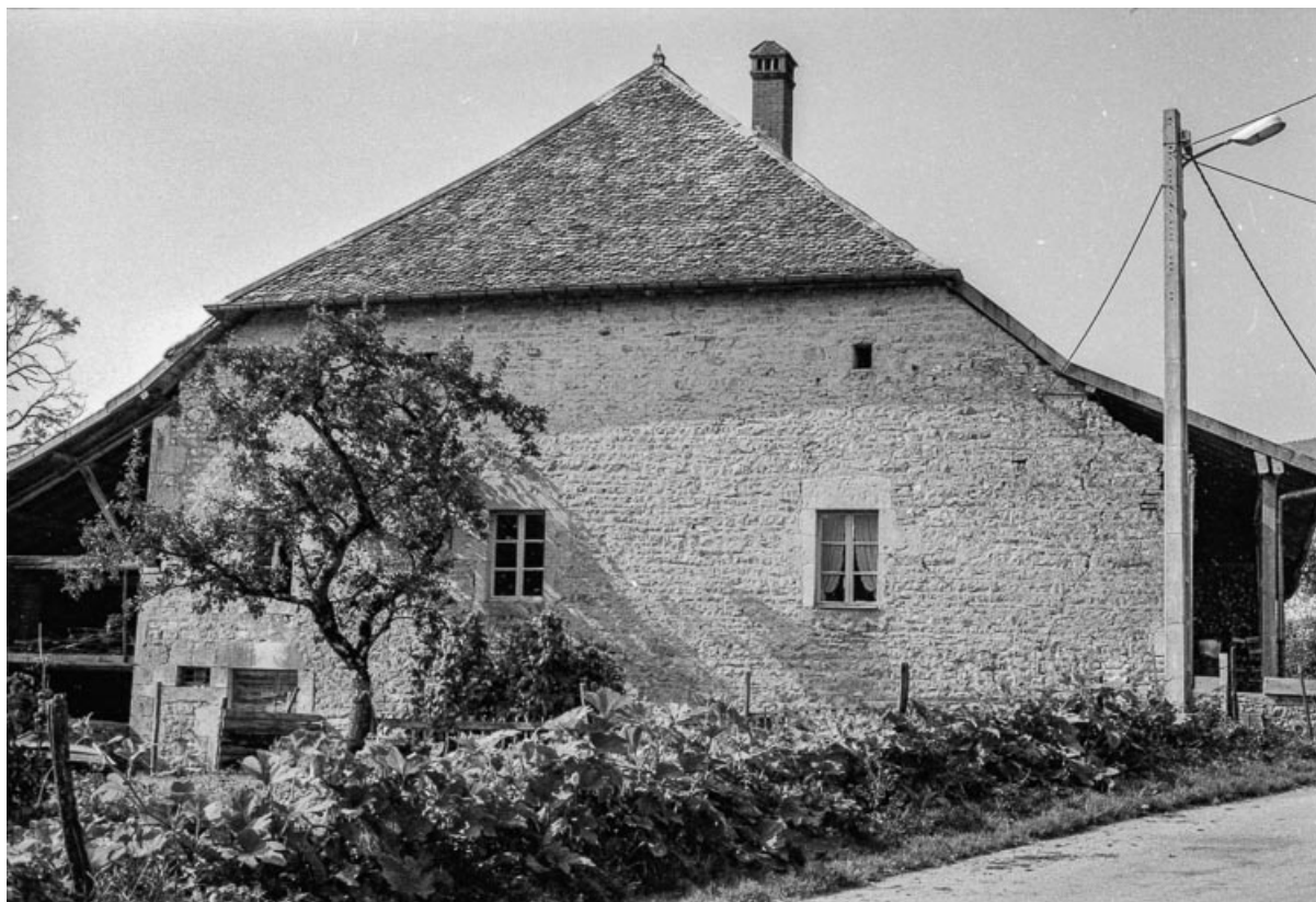
Ferme cadastrée 1961 AC 31 : façade latérale gauche. 25, Villeneuve-d'Amont
