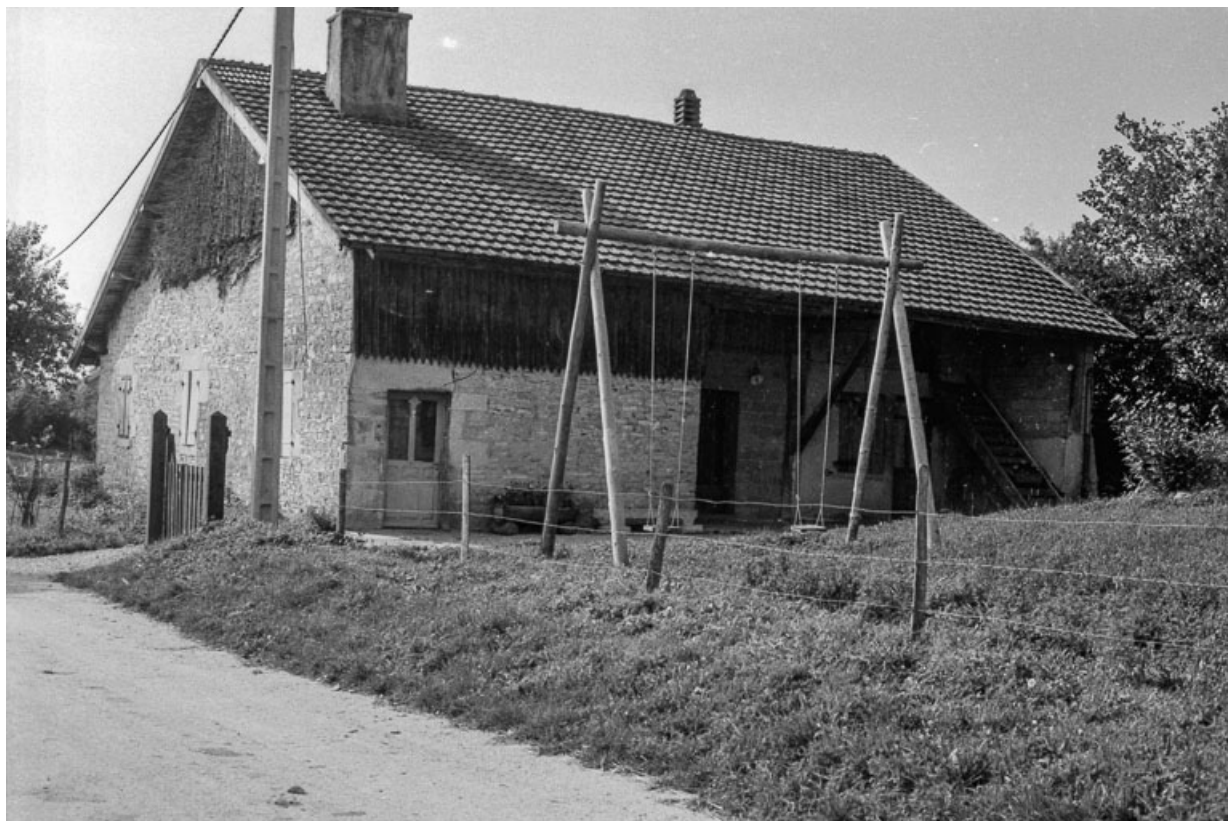
Ferme cadastrée 1961 B2 136 : façades antérieure et latérale gauche. 25, Villeneuve-d'Amont
