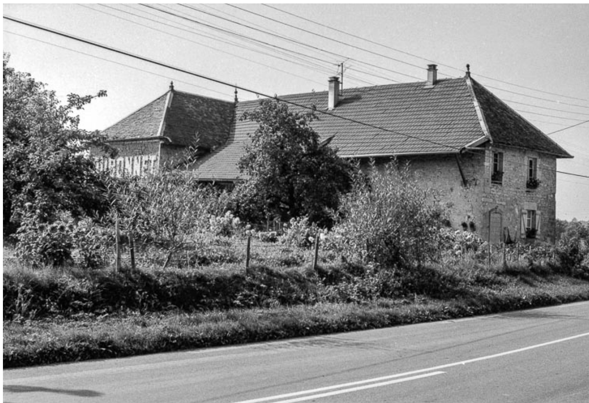
Ferme cadastrée 1961 AB 12, datée de 1771 : façades antérieure et latérale droite. 25, Villeneuve-d'Amont
