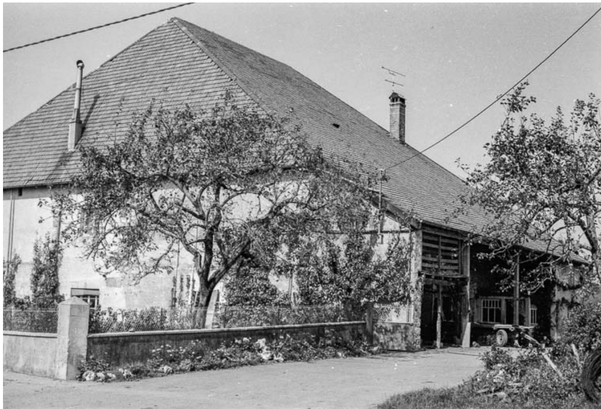
Ferme cadastrée 1961 AB 83 : façades antérieure et latérale droite. 25, Villeneuve-d'Amont
