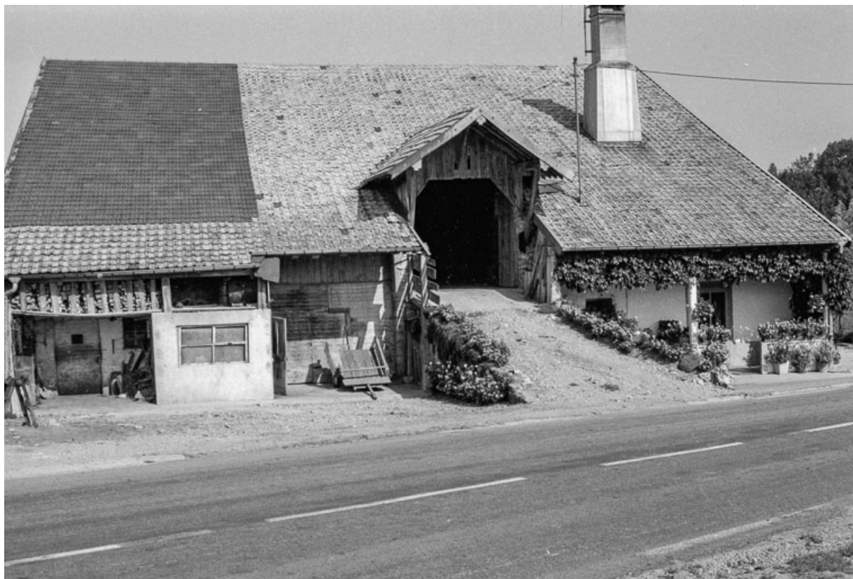
Ferme cadastrée 1961 AB 45 : façade sur rue avec levée de grange. 25, Villeneuve-d'Amont
