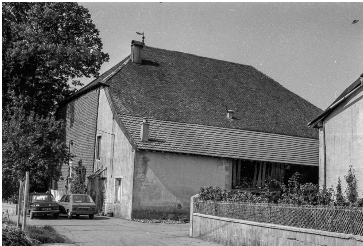
Ferme cadastrée 1961 AB 86 : façades antérieure et latérale droite. 25, Villeneuve-d'Amont
