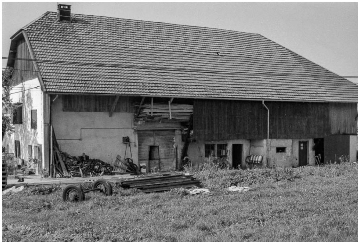
Ferme cadastrée 1961 AB 57 : façades antérieure et latérale droite. 25, Villeneuve-d'Amont
