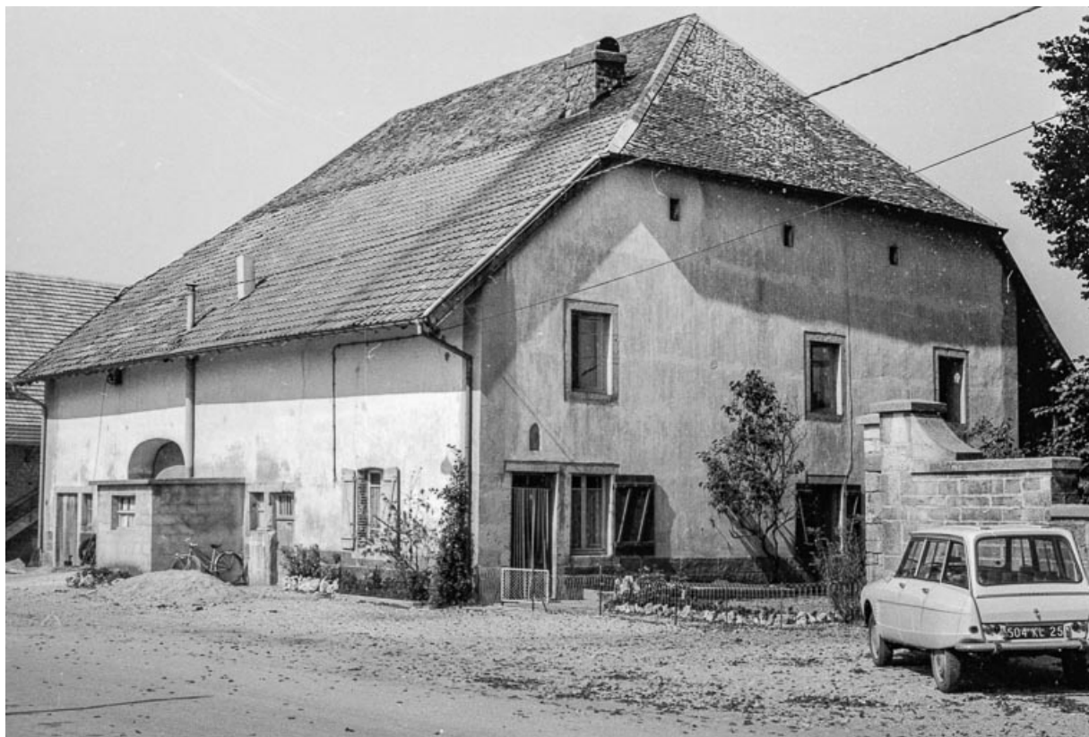
Ferme cadastrée 1961 AB 70 : façades antérieure et latérale gauche. 25, Villeneuve-d'Amont
