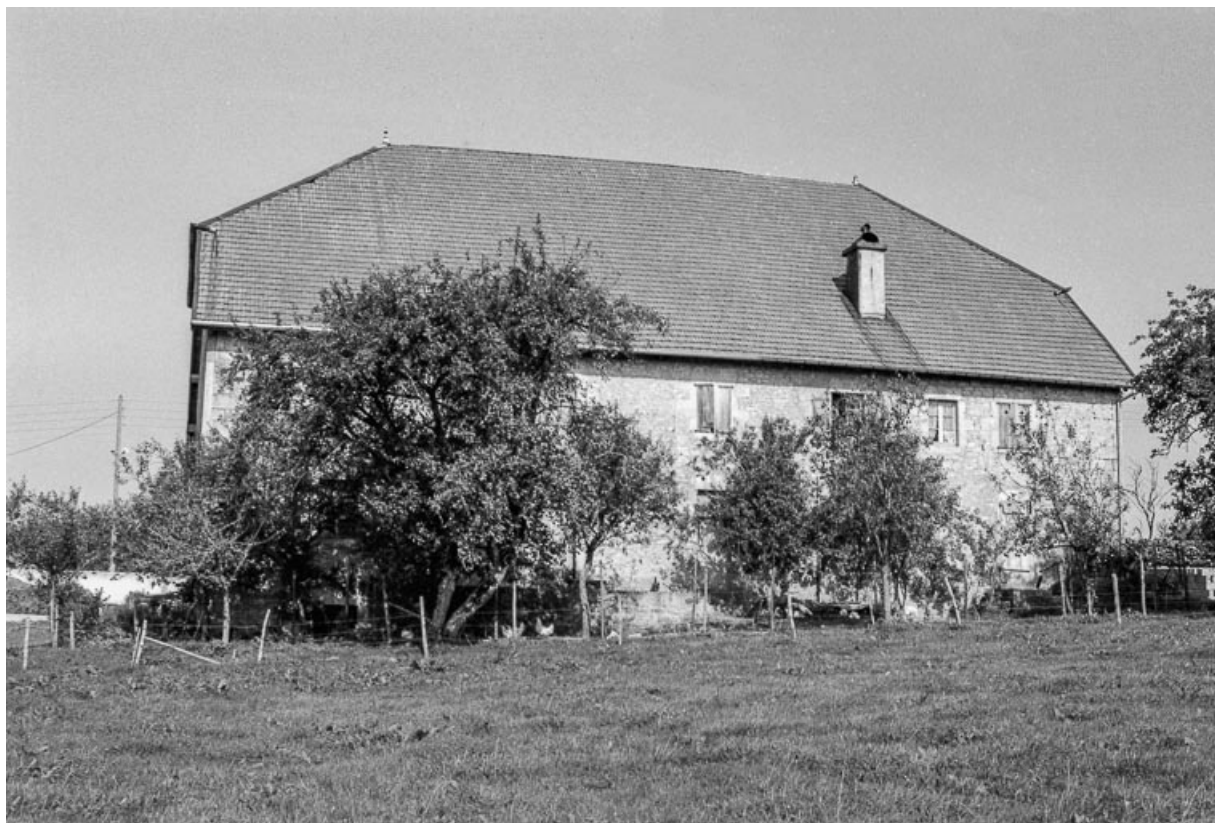
Ferme cadastrée 1961 AB 42 : vue d'ensemble. 25, Villeneuve-d'Amont
