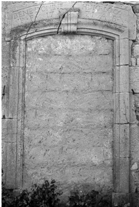
Ferme cadastrée 1961 AB 12, datée de 1771 : porte de 1771 avec inscription. 25, Villeneuve-d'Amont
