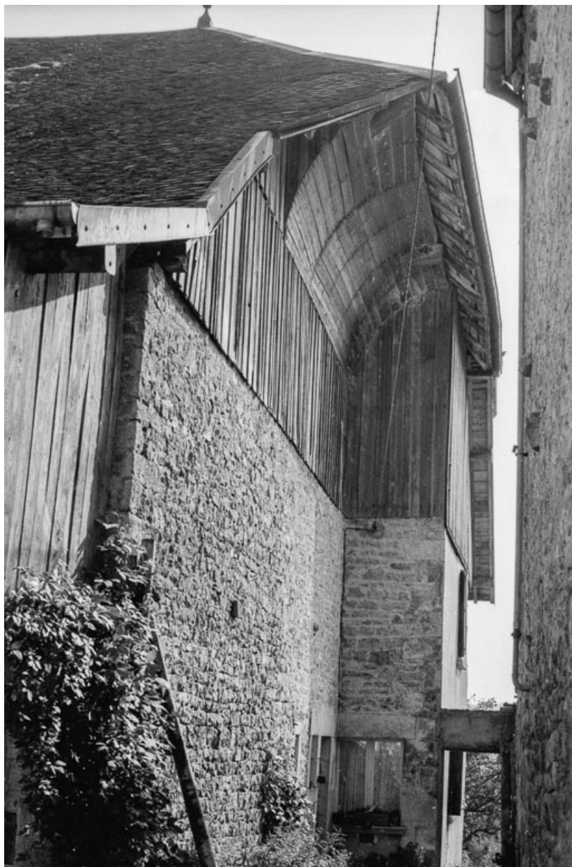
Ferme cadastrée 1961 AB 50 : façade postérieure (?). 25, Villeneuve-d'Amont
