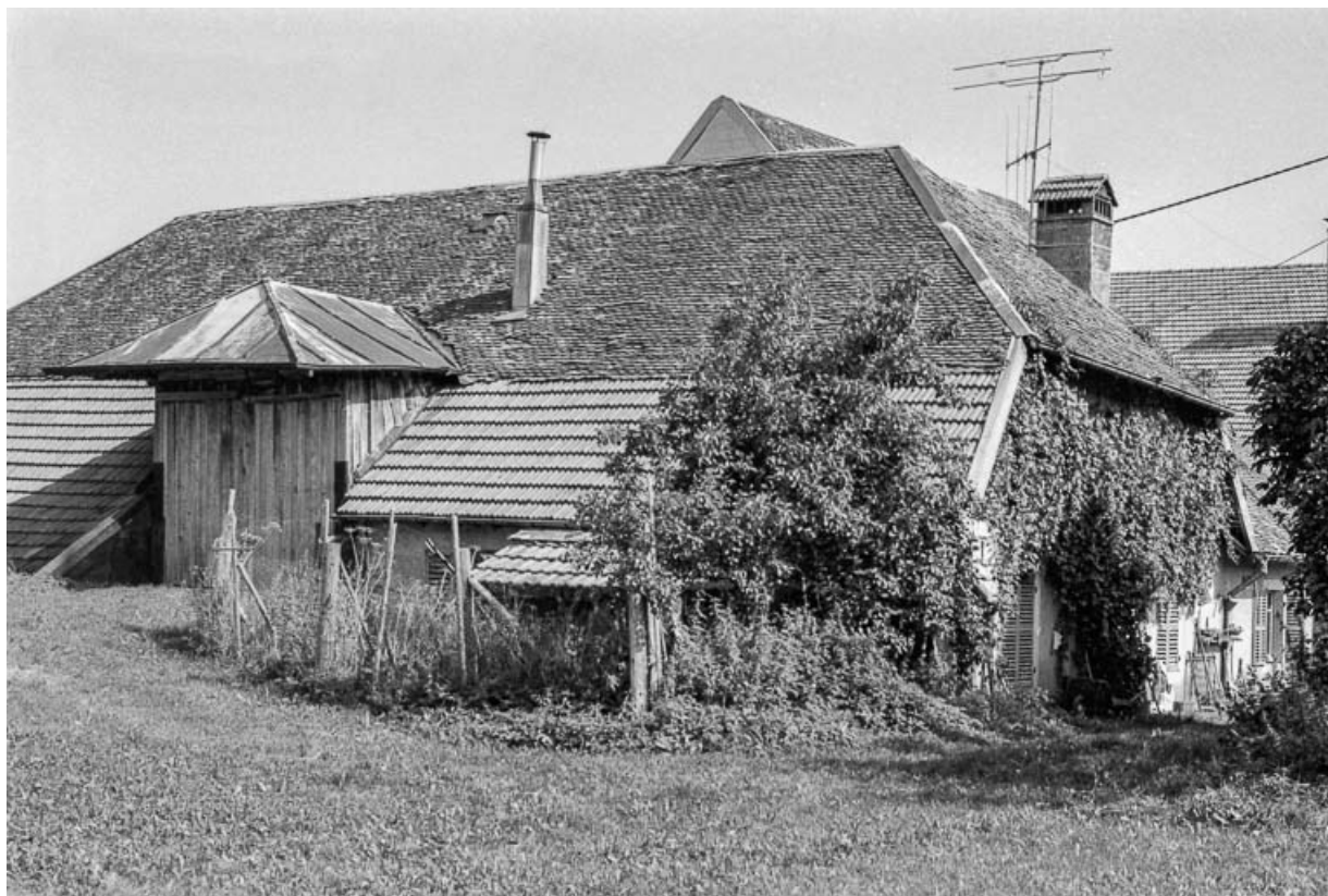
Ferme cadastrée 1961 AB 62 : façade latérale gauche. 25, Villeneuve-d'Amont
