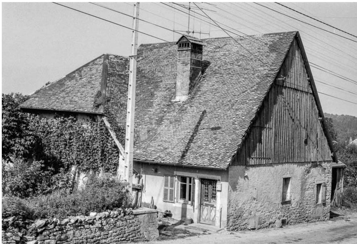
Ferme cadastrée 1961 AB 62 : façades antérieure et latérale droite. 25, Septfontaines
