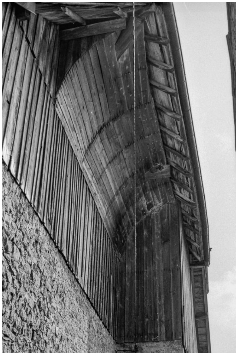
Ferme cadastrée 1961 AB 50 : bardage. 25, Villeneuve-d'Amont
