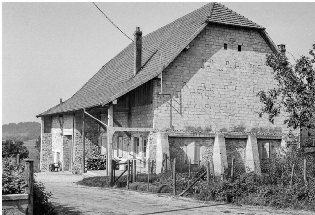
Ferme cadastrée 1961 AB 31 : façades antérieure et latérale droite. 25, Villeneuve-d'Amont
