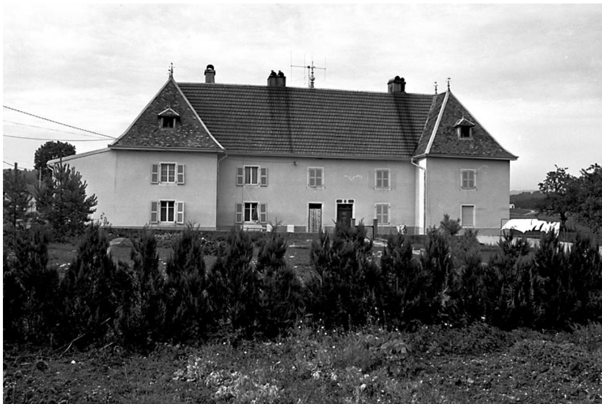
Façade de la partie d'habitation traitée en façade de "château". 25, Sombacour
