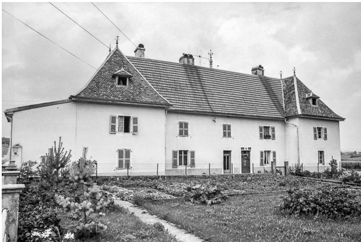
Façade de la partie d'habitation traitée en façade de "château". 25, Sombacour, 18 Grande Rue
