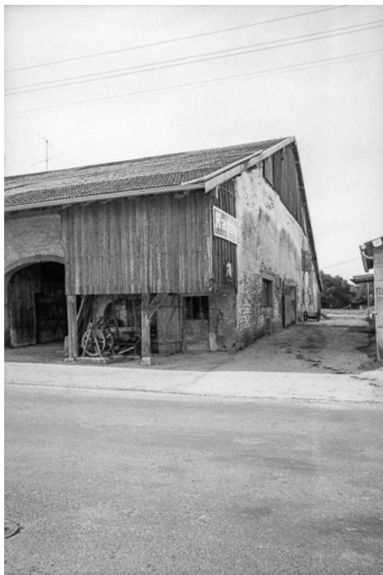
Partie gauche de la façade sur rue et façade postérieure. 25, Sombacour, 16 Grande Rue
