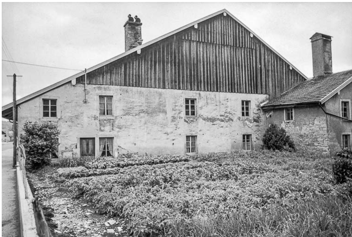
Façade antérieure et jardin.
