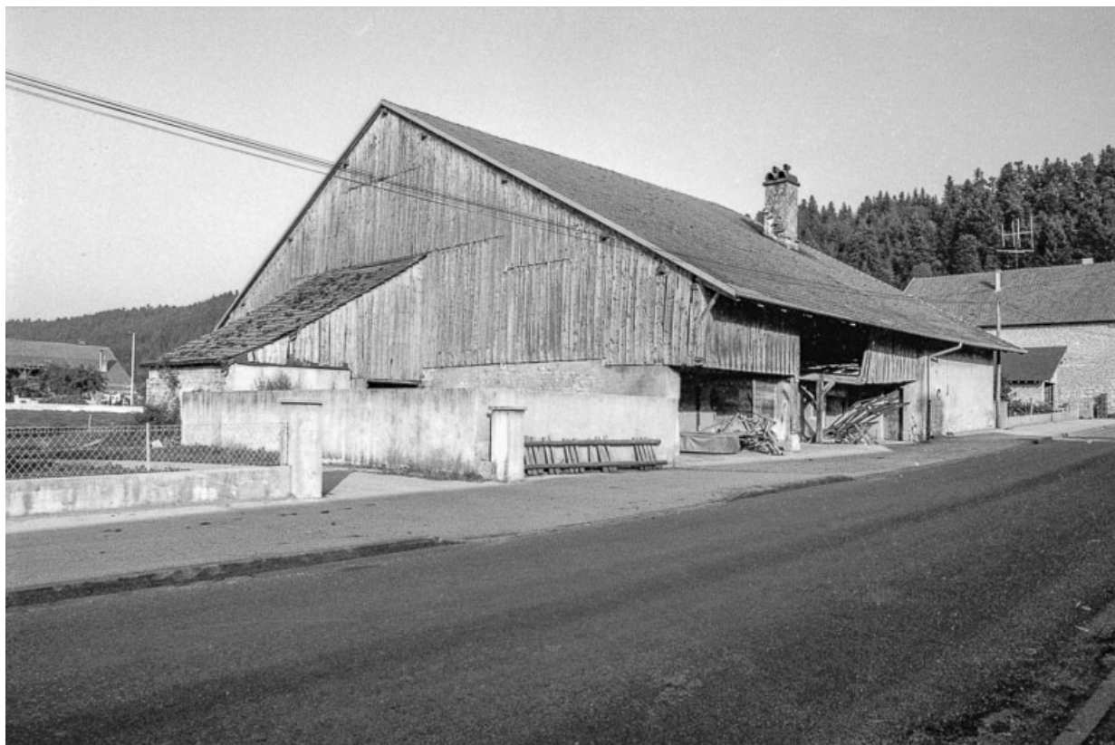
Façades postérieure et latérale gauche.
