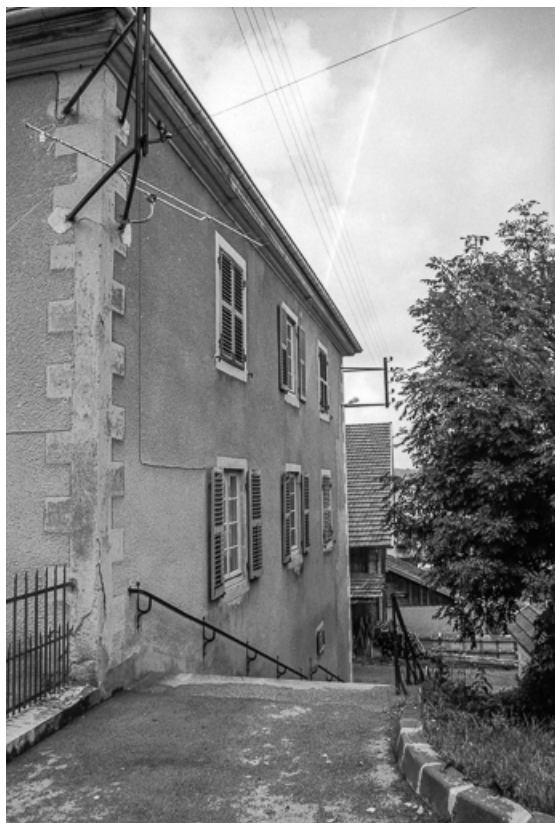
Façade latérale gauche (?). 25, Sombacour, 6 Grande Rue
