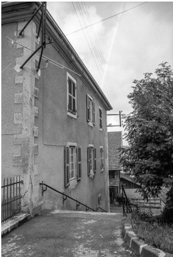
Façade latérale gauche (?) . 25, Sombacour, 6 Grande Rue
