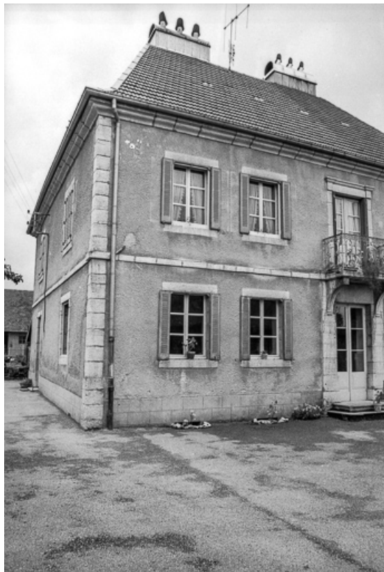
Partie gauche de la façade antérieure et façade latérale gauche.
