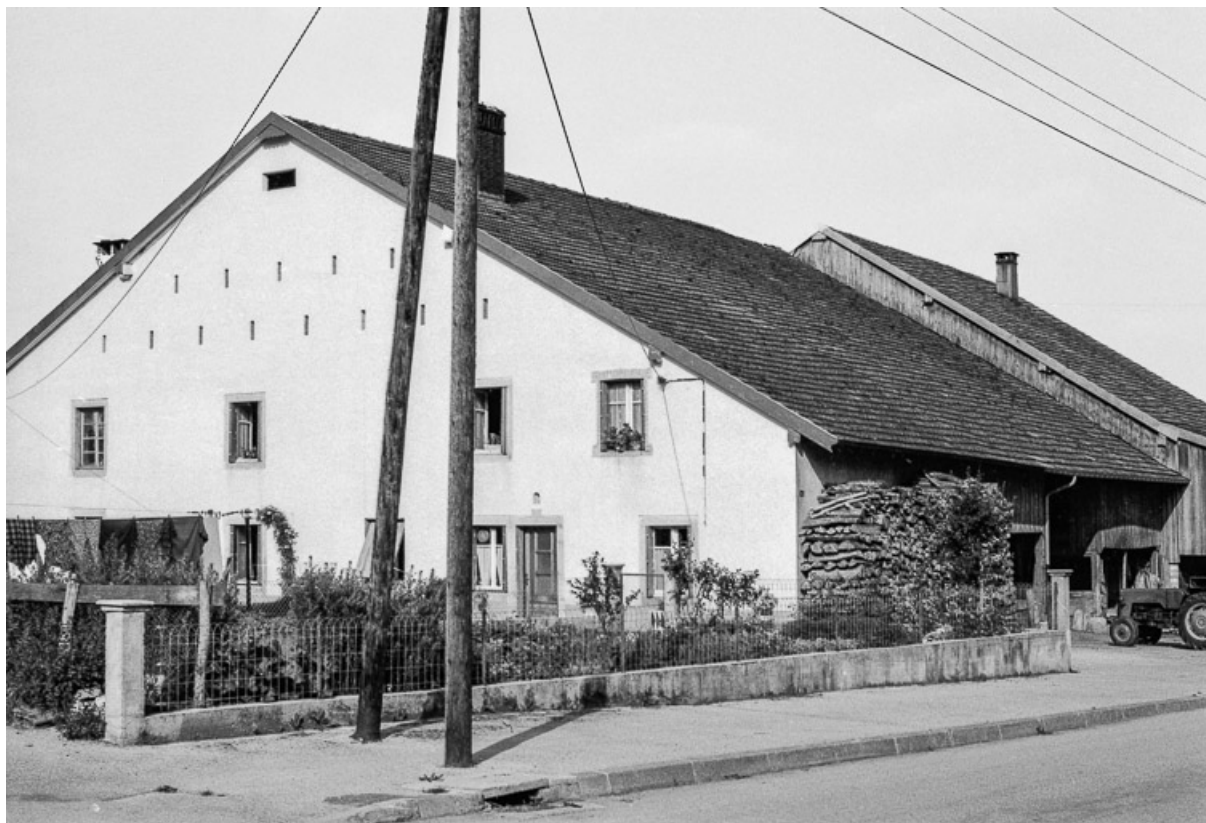
Ferme cadastrée 1962 E 174-175 : façades antérieure et latérale droite. 25, Sombacour
