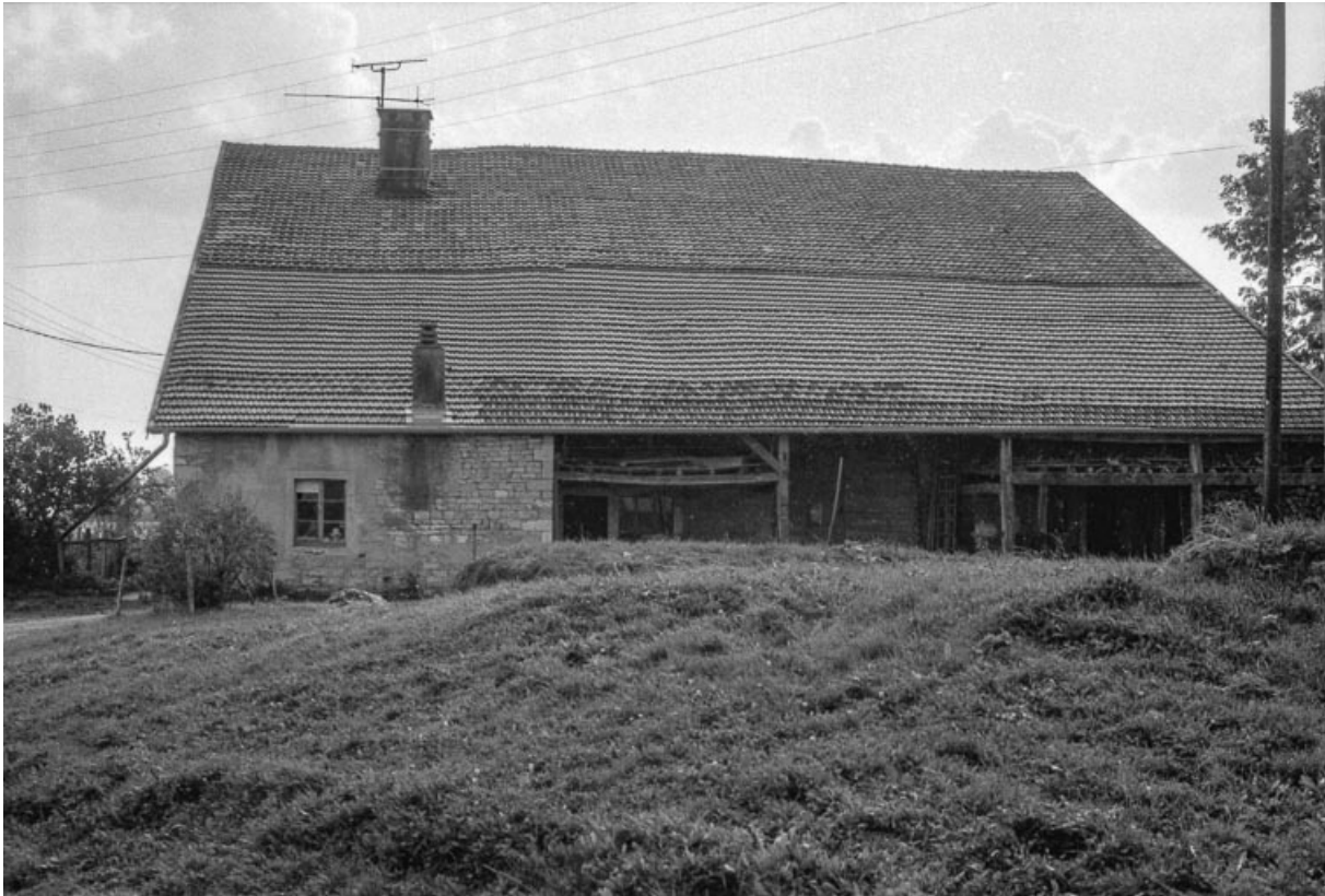
Façade latérale droite.
