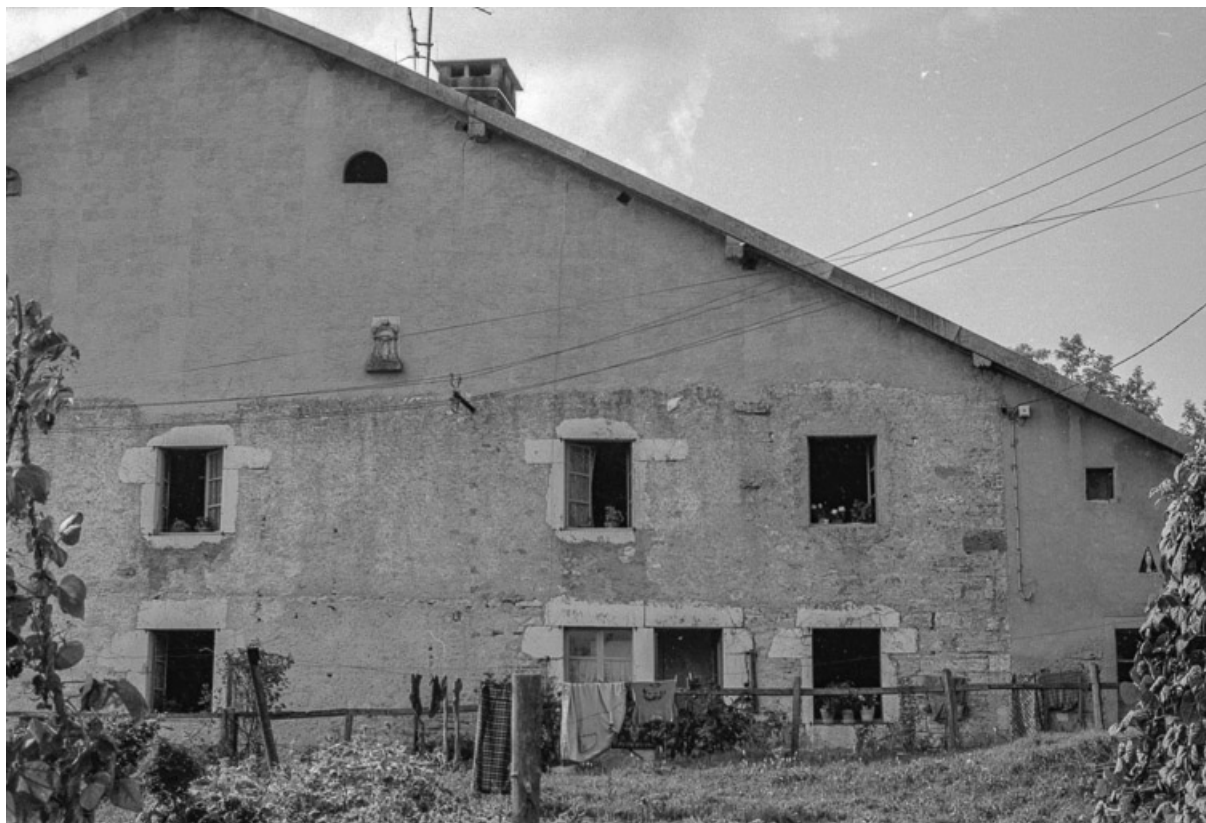
Façade antérieure : partie droite.
