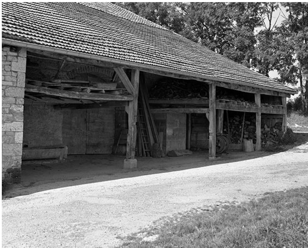
Façade latérale droite.
