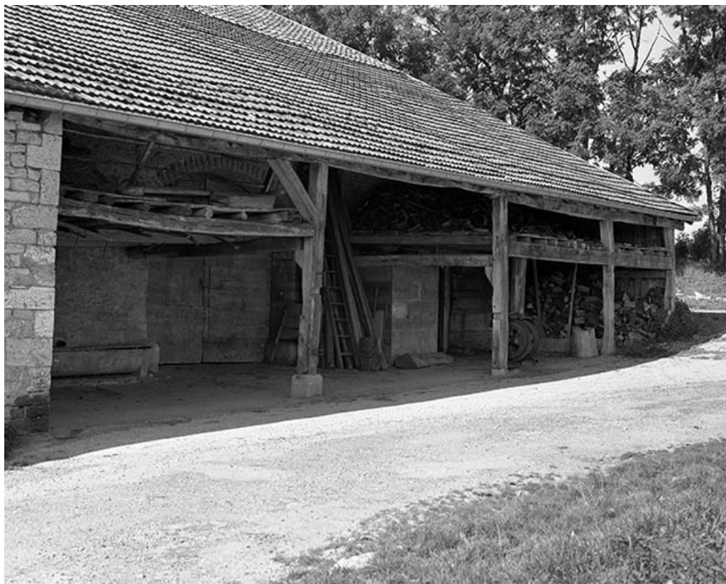
Façade latérale droite.
