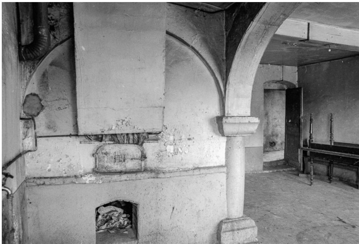
Cuisine : pilier central et porte menant au couloir voûté.
