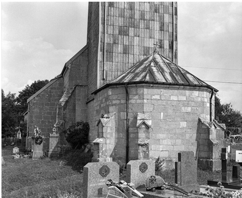
Porche : côté ouest.
