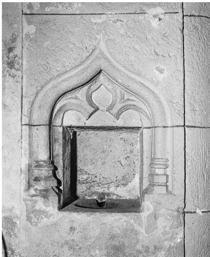
Lavabo de la chapelle latérale gauche.
