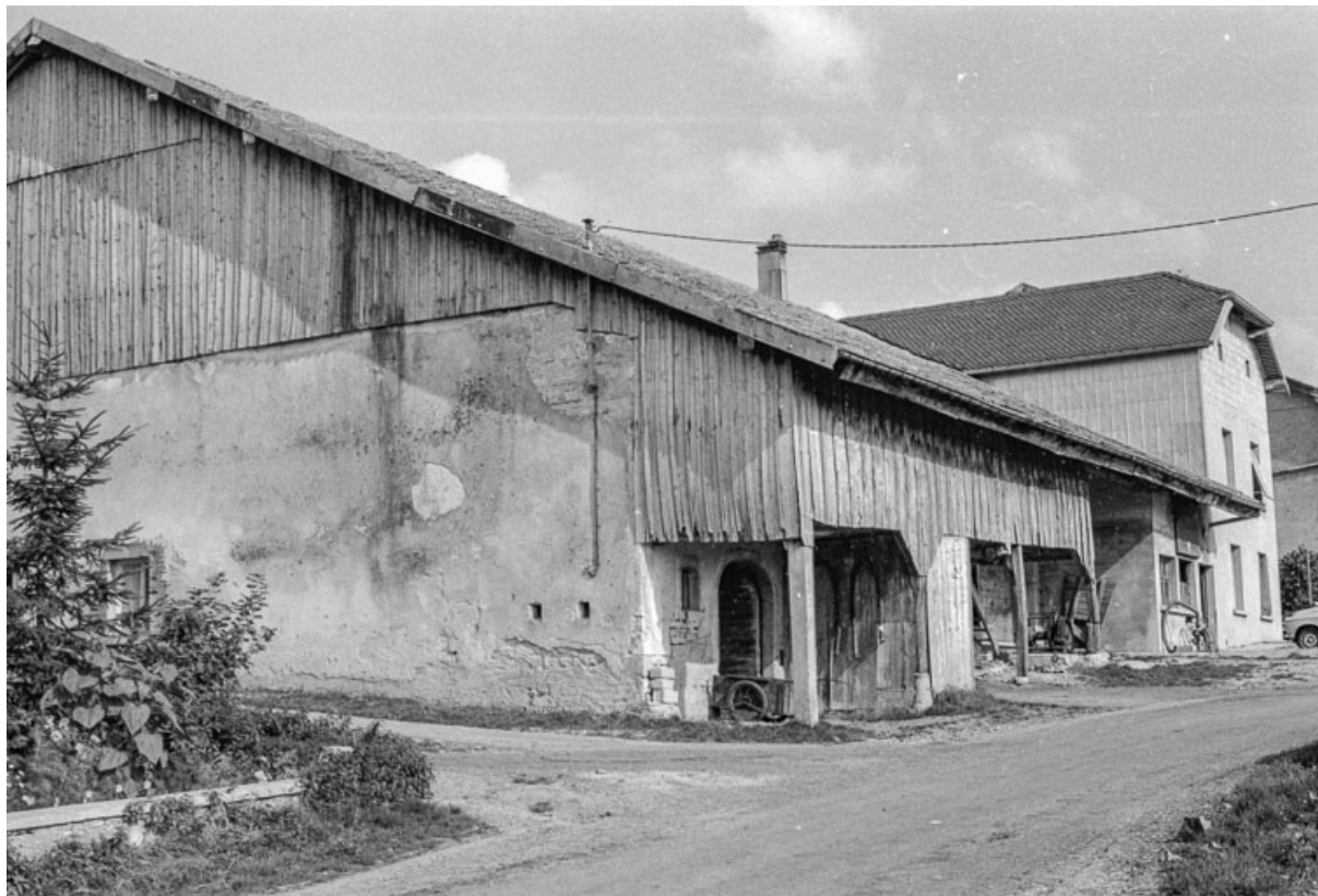
Ferme cadastrée 1945 D 128-129 : façade sur rue. 25, Septfontaines
