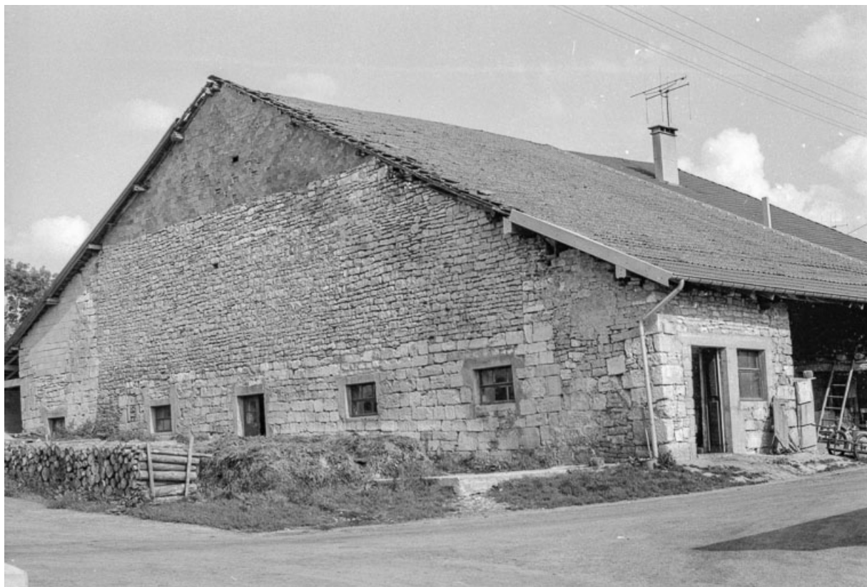
Ferme cadastrée 1945 D 120 : vue d'ensemble. 25, Septfontaines
