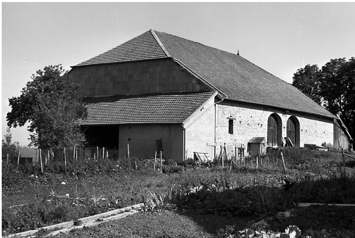
Vue d'ensemble. 25, Septfontaines
