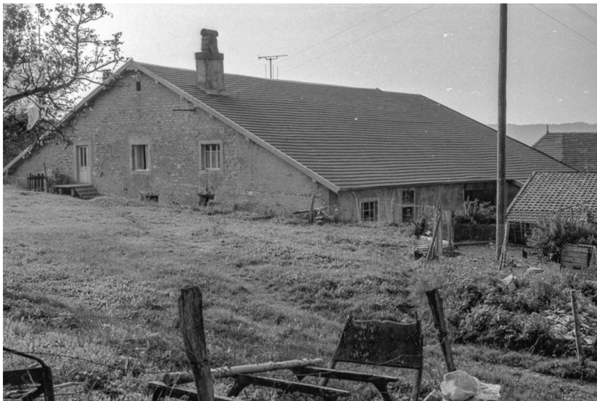
Ferme cadastrée 1945 D 180-181 : vue d'ensemble. 25, Septfontaines
