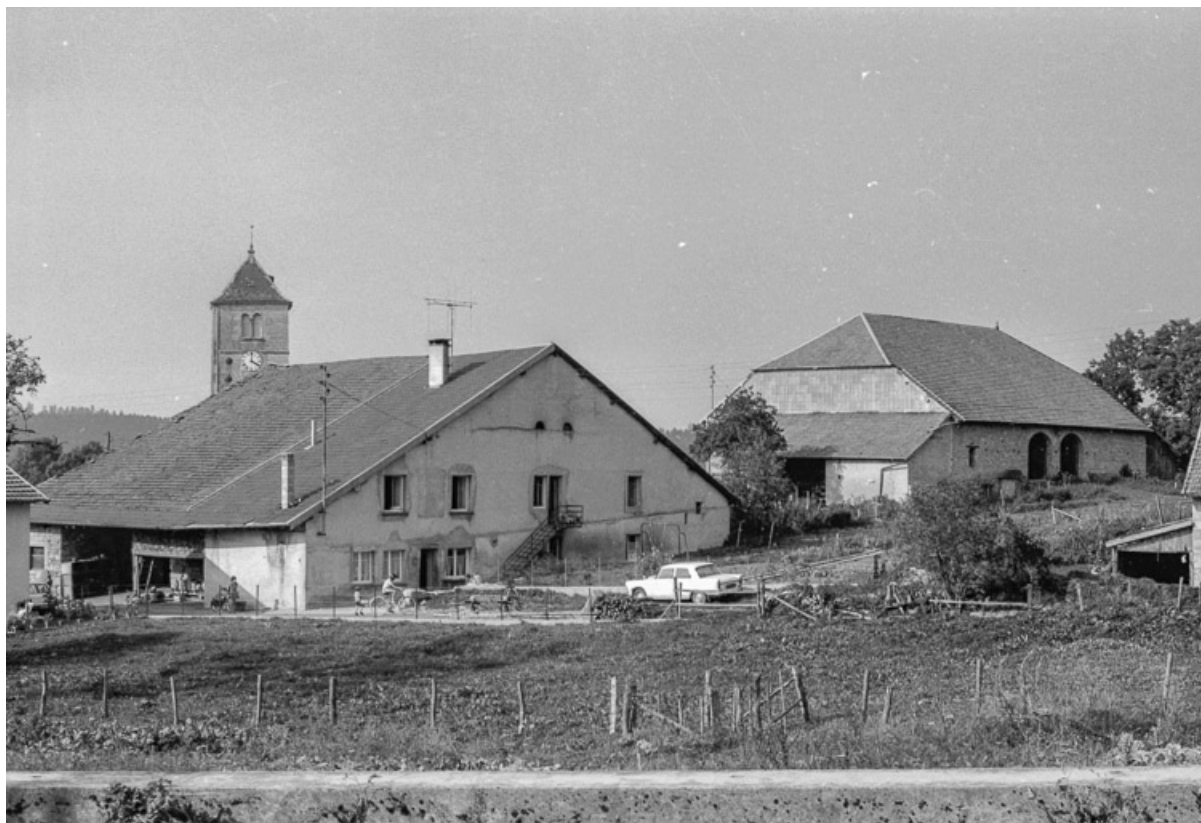
Ferme située rue de l'Eglise, cadastrée 1945 D 120-123 25, Septfontaines
