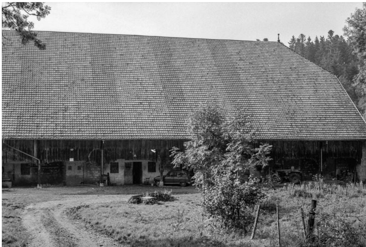
Façade latérale droite.
