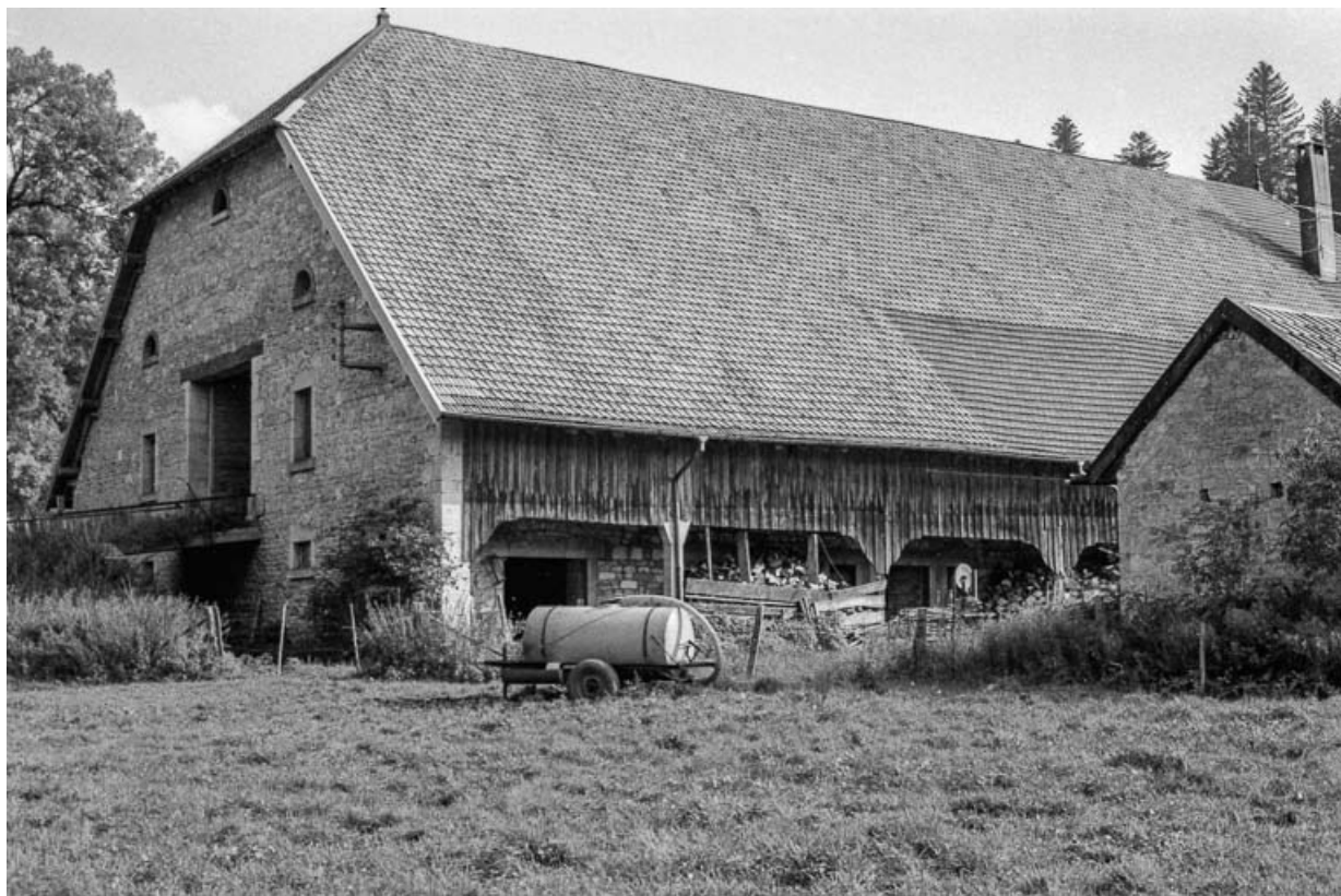
Façades postérieure et latérale gauche.
