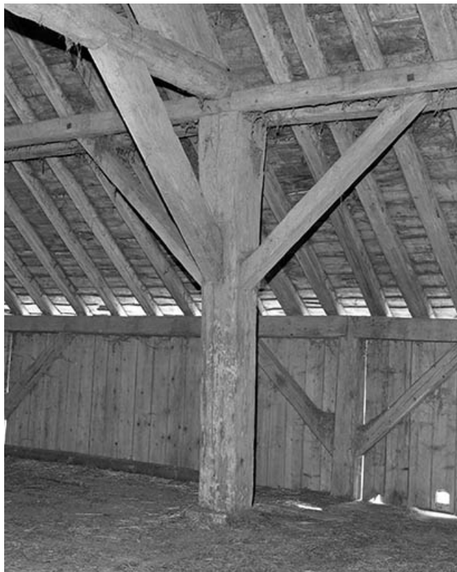
Charpente, partie inférieure au niveau d'une ferme.
