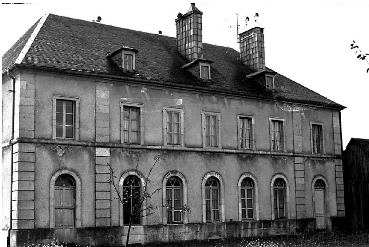
Façade latérale droite.
