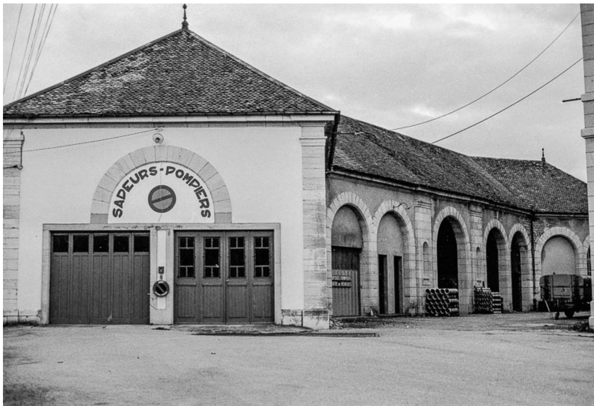
Vue des parties constituantes : remise sapeurs-pompiers.
