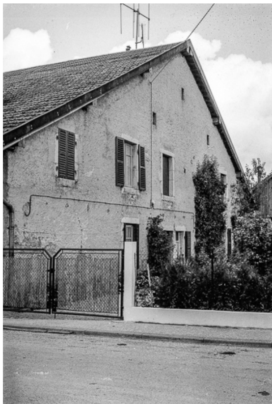
Ferme située 13 rue du Moutet : façade latérale droite. 25, Levier
