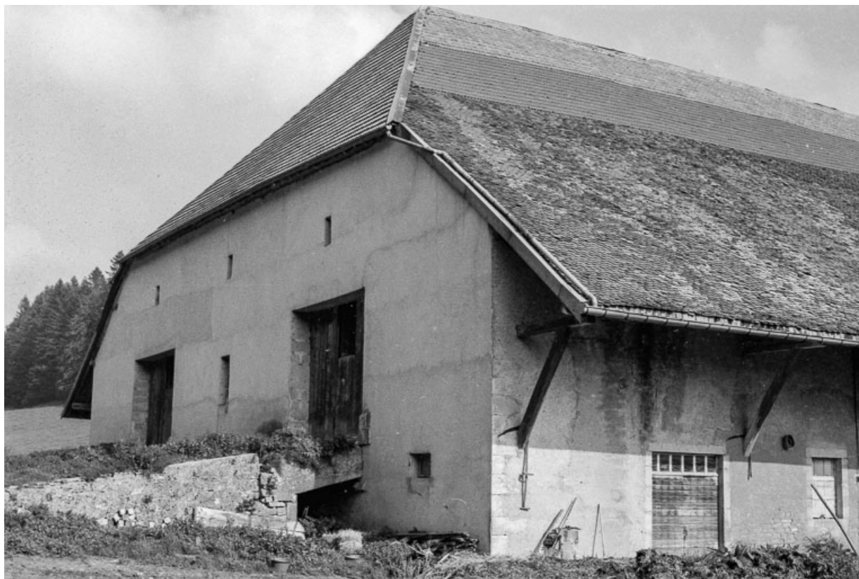
Ferme cadastrée 1954 D 8, située au lieudit Granges Maillot, L'Hermitage : façades postérieure et latérale gauche. 25, Levier
