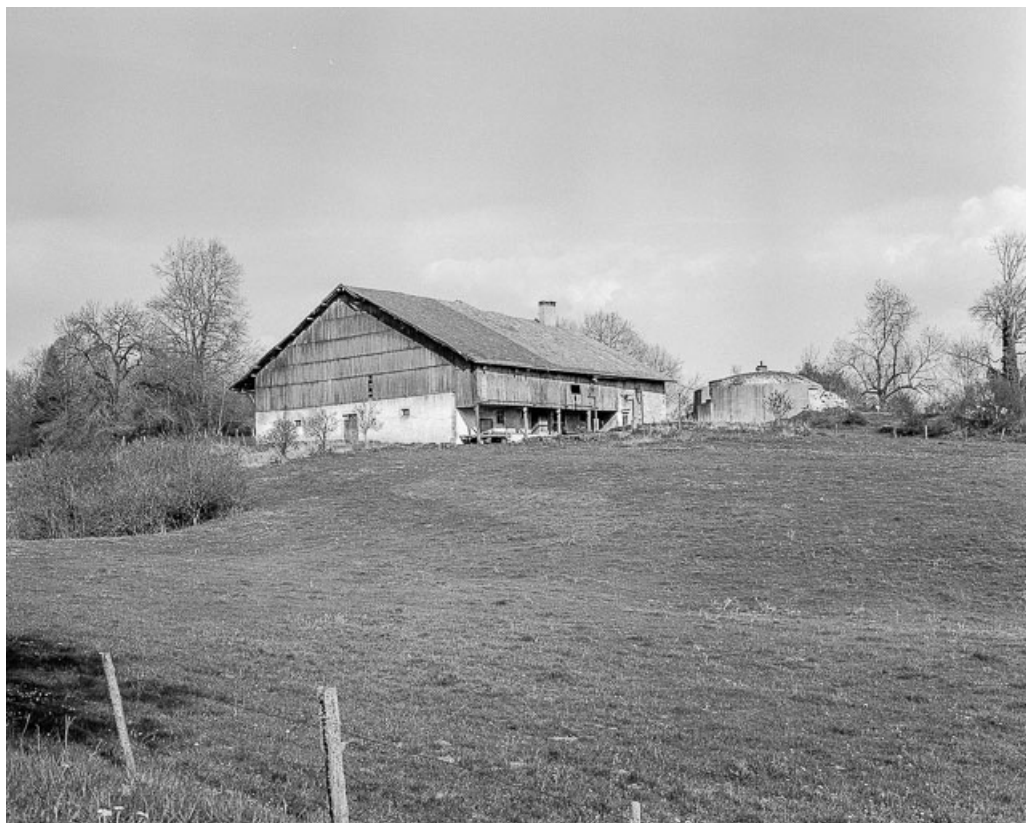
Ferme de la Part, située au lieudit Granges Maillot : vue d'ensemble. 25, Levier
