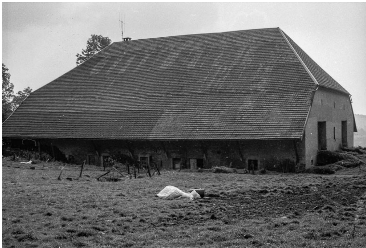
Ferme cadastrée 1954 D 8, située au lieudit Granges Maillot, L'Hermitage : façade postérieure. 25, Levier
