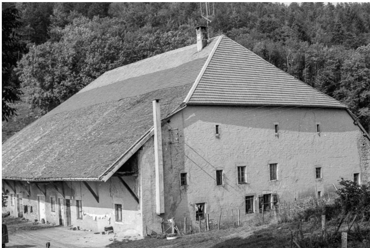
Ferme cadastrée 1954 D 8, située au lieudit Granges Maillot, L'Hermitage : façades antérieure et latérale droite. 25, Levier
