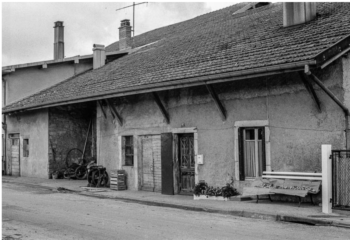
Ferme située 13 rue du Moutet : façade antérieure. 25, Levier
