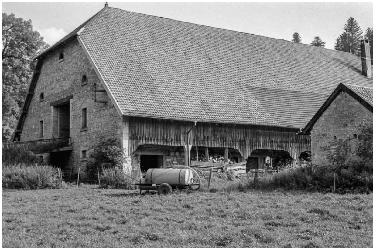
Façades postérieure et latérale gauche.
