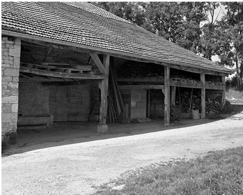
Façade latérale droite.
