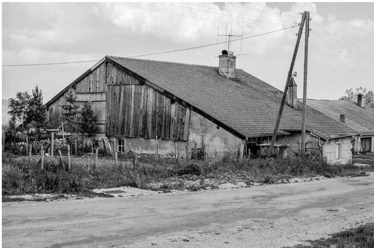
Ferme située 32 rue de Salins : façades latérale et postérieure avec débord de la partie habitation, pignon fermé par des planches et montée de grange.
