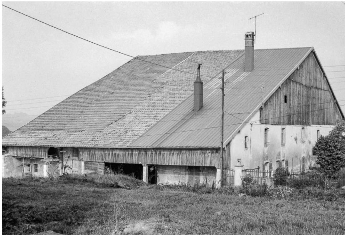
Façades antérieure et latérale gauche sur rue.
