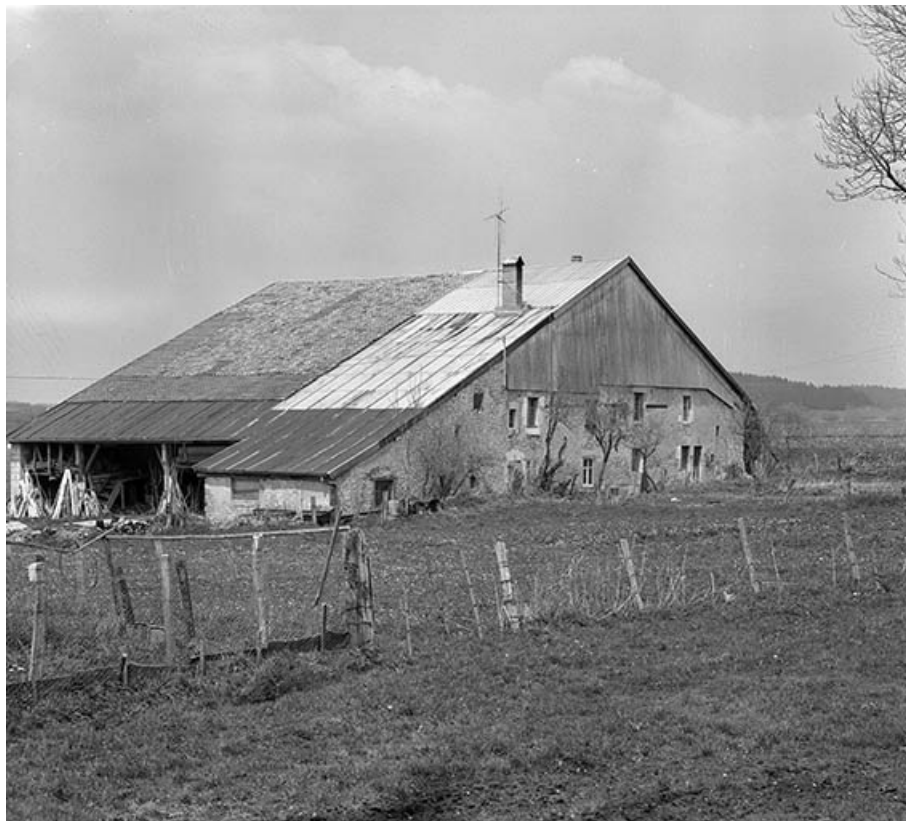
Extérieur : vue d'ensemble.
