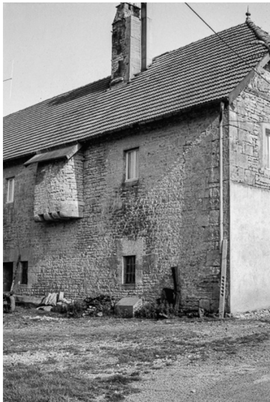
Partie droite de la façade postérieure avec le cul-du-four extérieur suspendu. 25, Villeneuve-d'Amont, lieudit : Lioche
