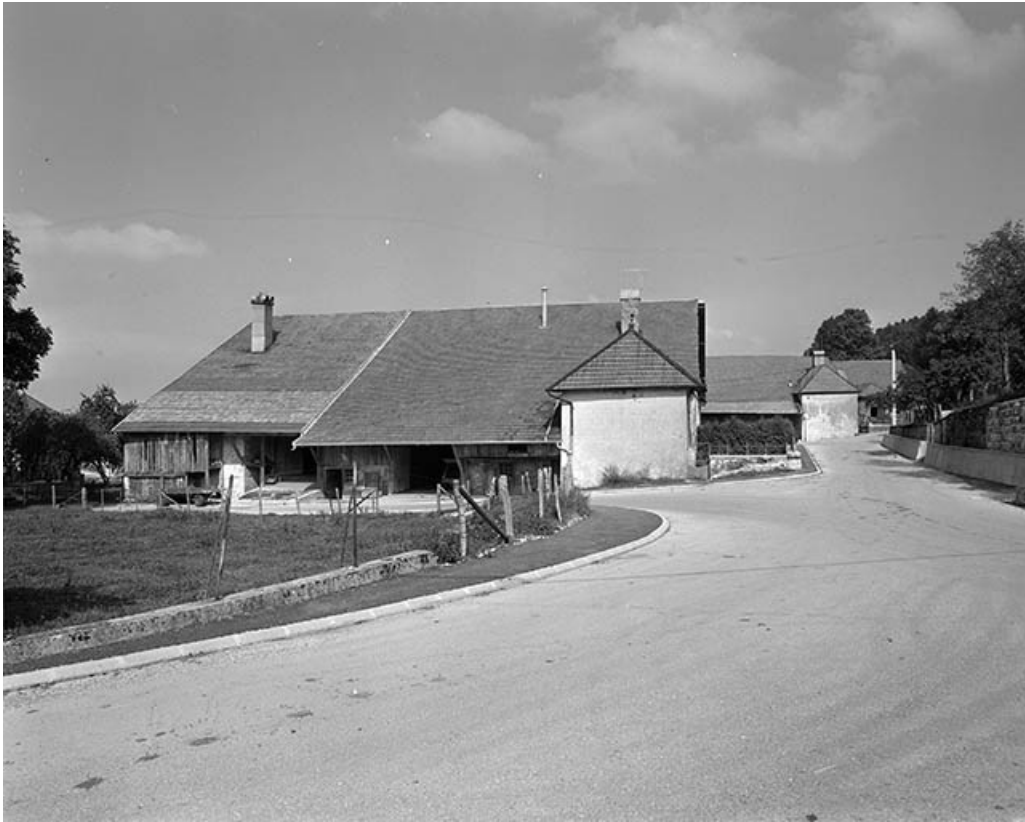
Vue d'ensemble des fermes.
