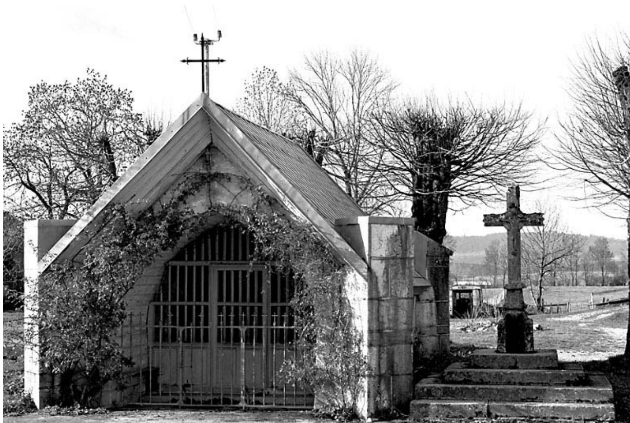
Façade antérieure et croix monumentale.
