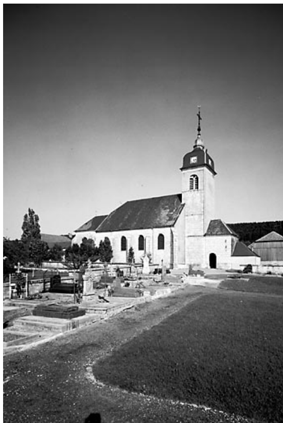
Façade latérale gauche et cimetière.
