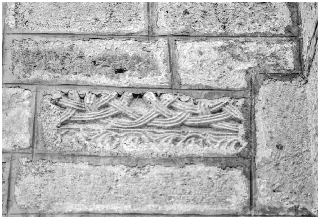
Extérieur : détail mur droit de la nef.
