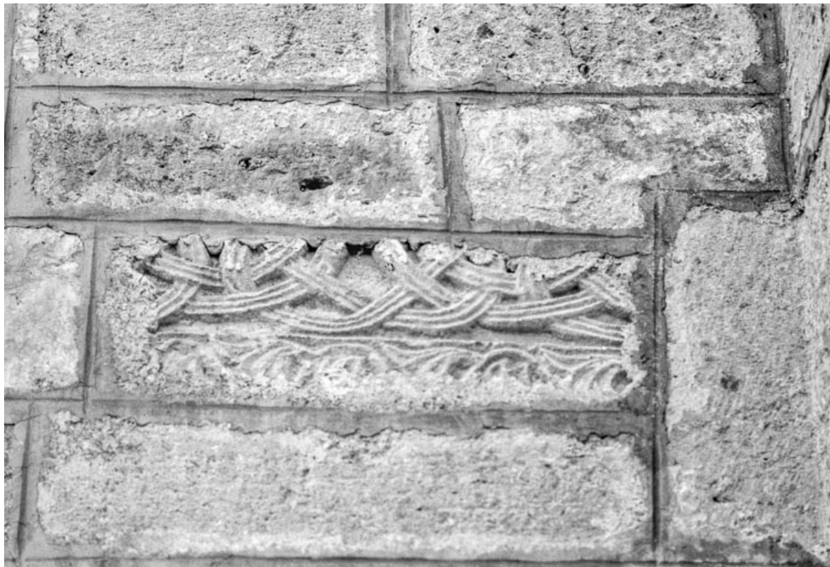
Extérieur : détail mur droit de la nef.
