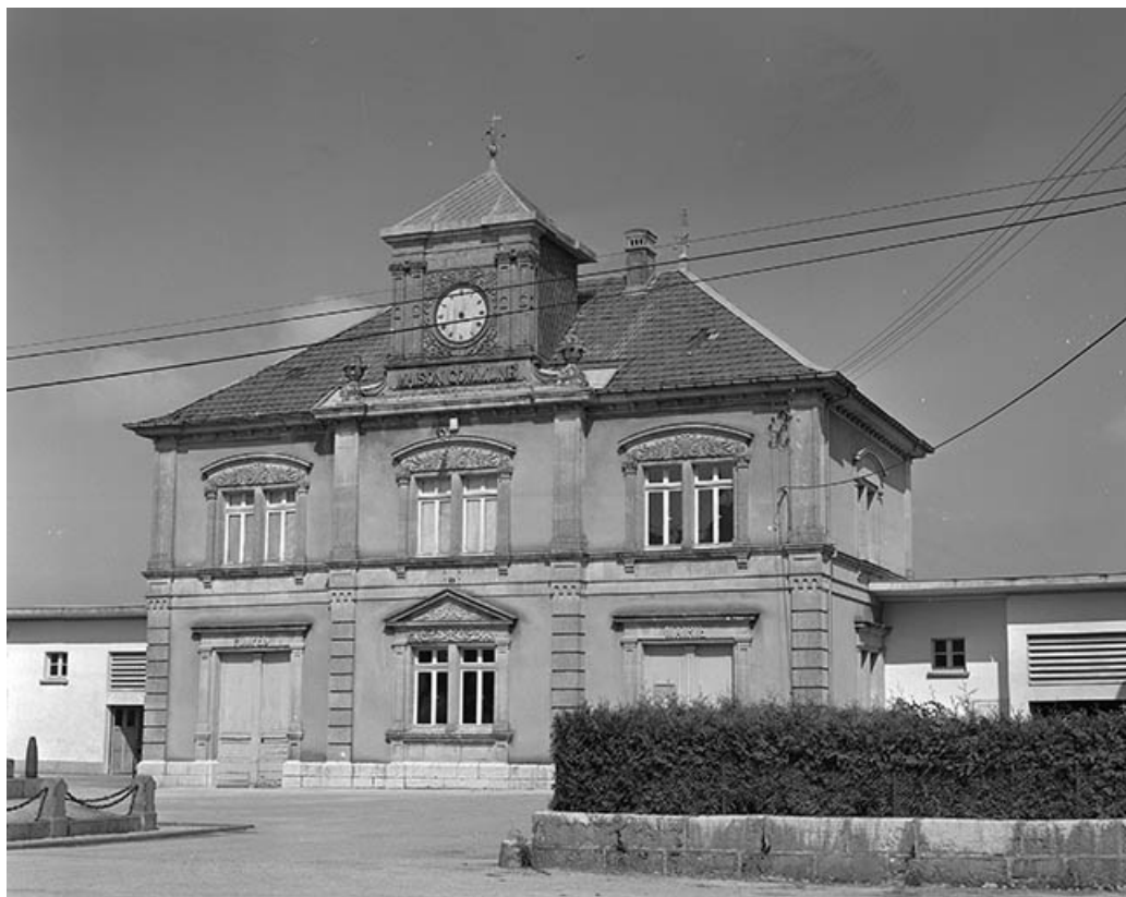
Façades antérieure et latérale droite. 25, Goux-les-Usiers, 9 rue des Ecoles
