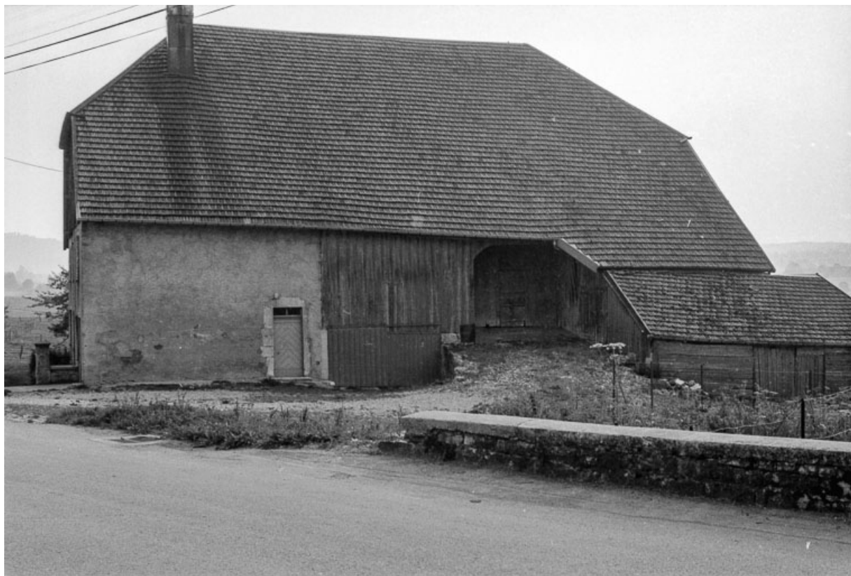
Façade latérale droite. 25, Goux-les-Usiers
