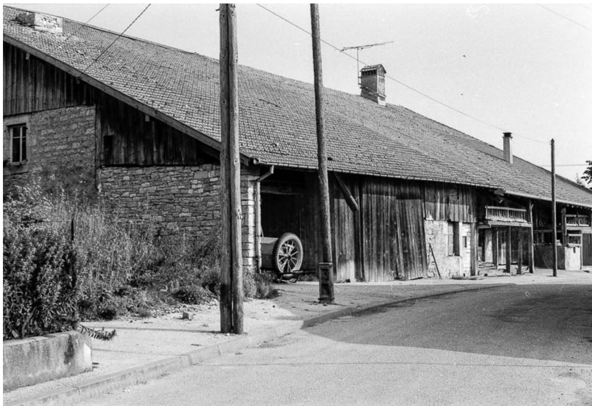
Ferme : façade sur rue. 25, Goux-les-Usiers
