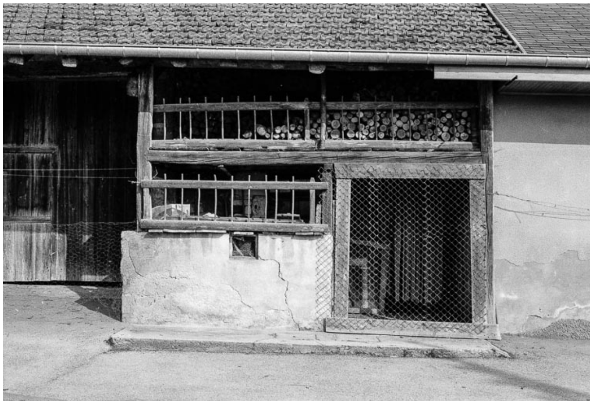
Ferme : détail de la façade antérieure. 25, Goux-les-Usiers
