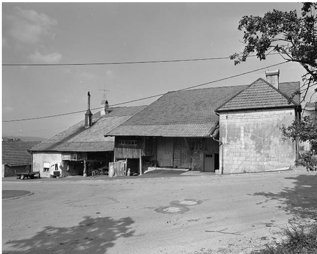
Gouttereau sur rue. 25, Goux-les-Usiers
