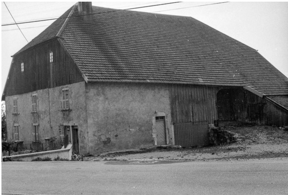
Ferme : façades antérieure et latérale droite. 25, Goux-les-Usiers
