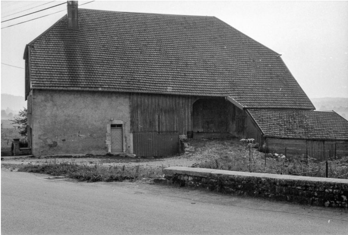
Façade latérale droite.
