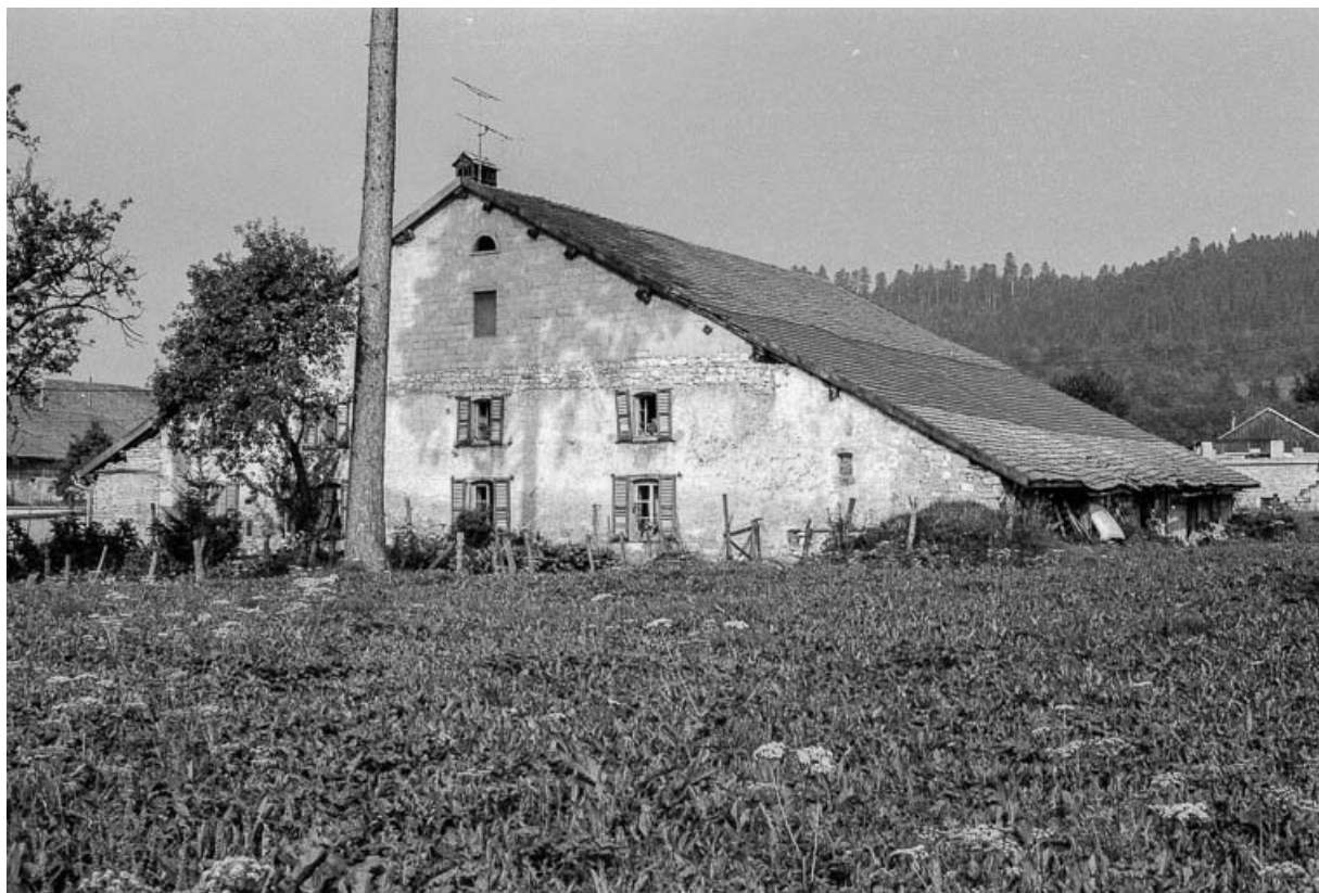
Ferme : façades antérieure et latérale droite. 25, Goux-les-Usiers
