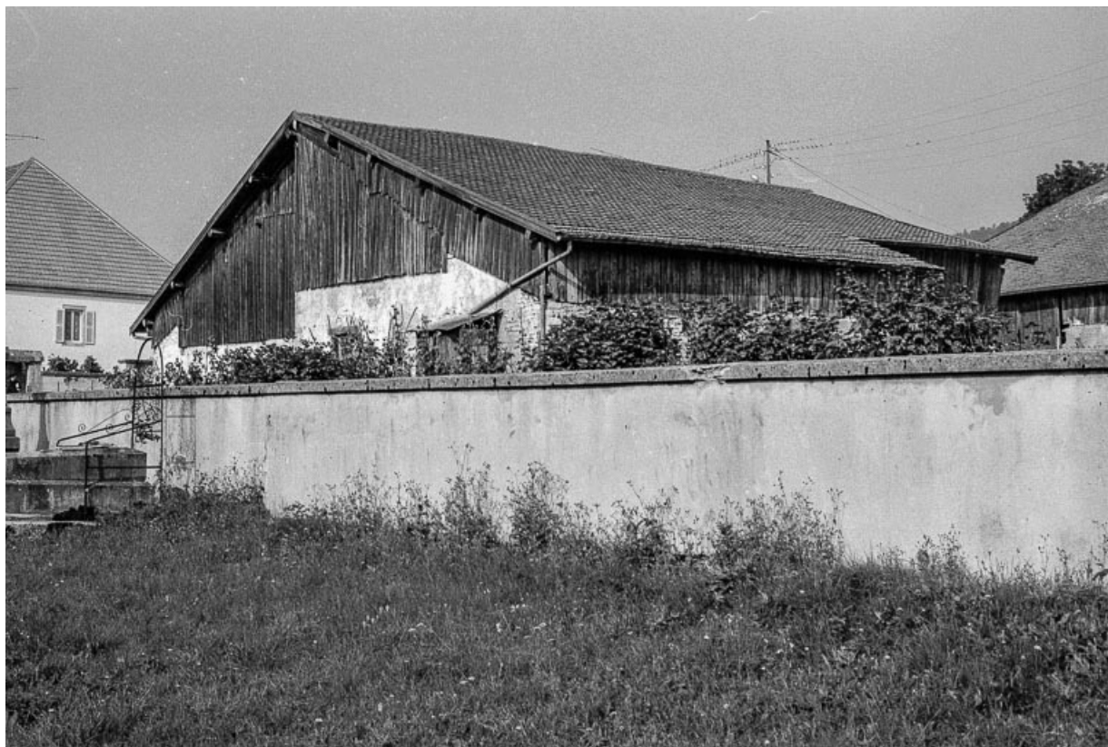
Ferme : façades postérieure et latérale droite. 25, Goux-les-Usiers
