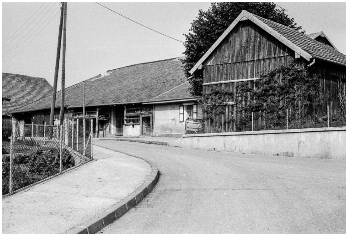
Ferme : vue d'ensemble depuis la rue. 25, Goux-les-Usiers
