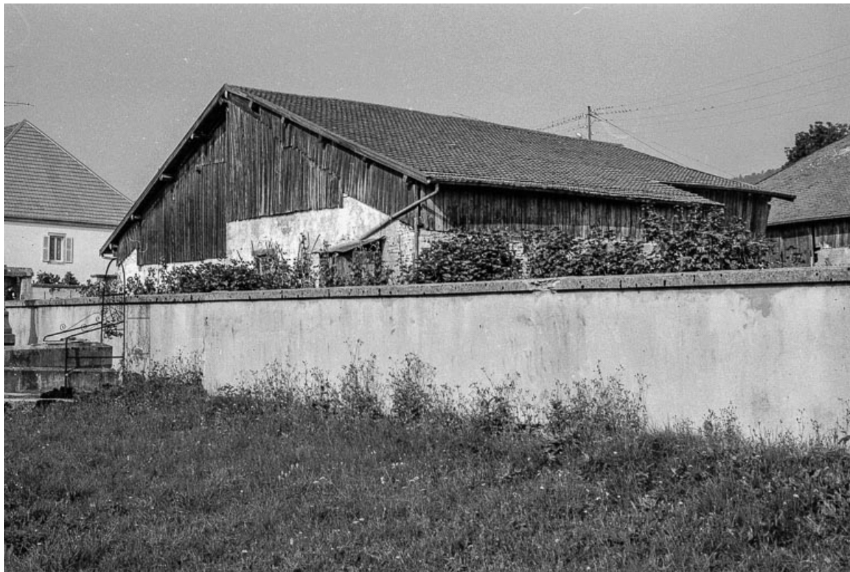
Ferme : façades postérieure et latérale droite. 25, Goux-les-Usiers
