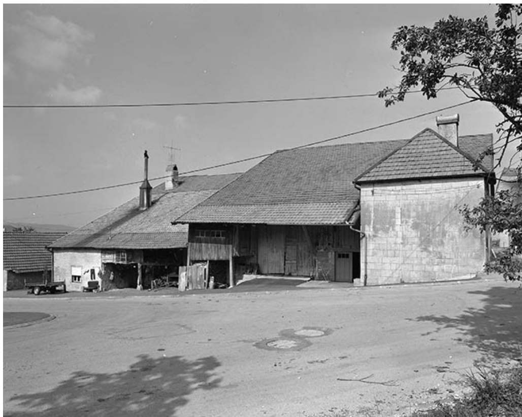
Gouttereau sur rue. 25, Goux-les-Usiers
